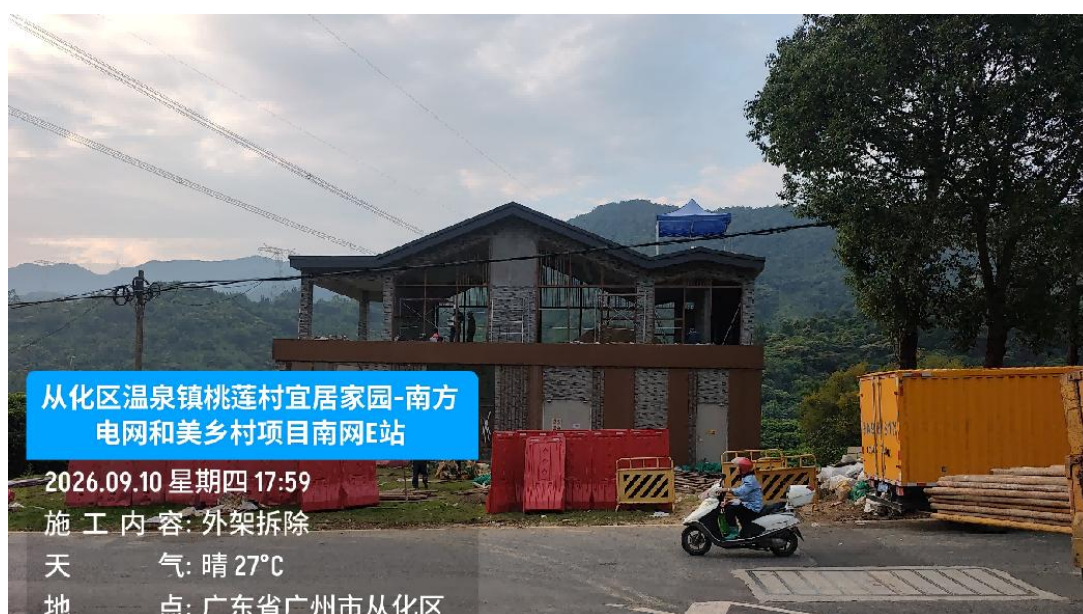
图为从化区桃莲村南网 E 站外建设情况
