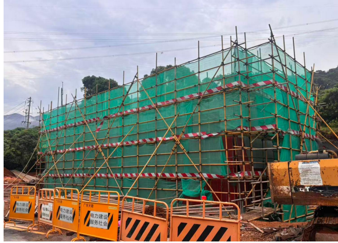
图为从化区桃莲村南网 E 站建设情况
