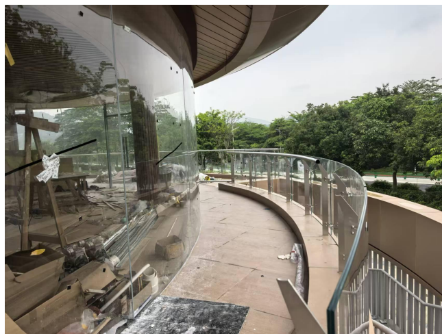
图为从化区高沙村南网 E 站外立面施工情况
