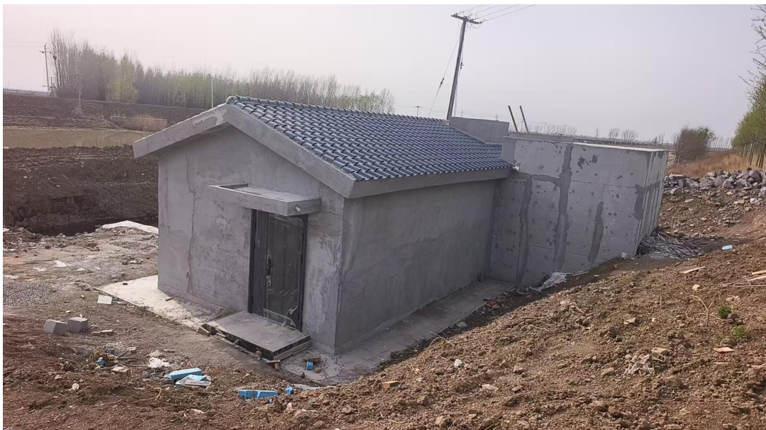
天津市武清区黄庄街道马家口水泵房施工现场照片
