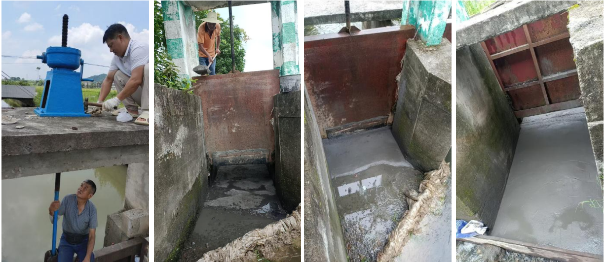
(图 2-图 5: 湖南船形岭村安装河道闸门设备)
