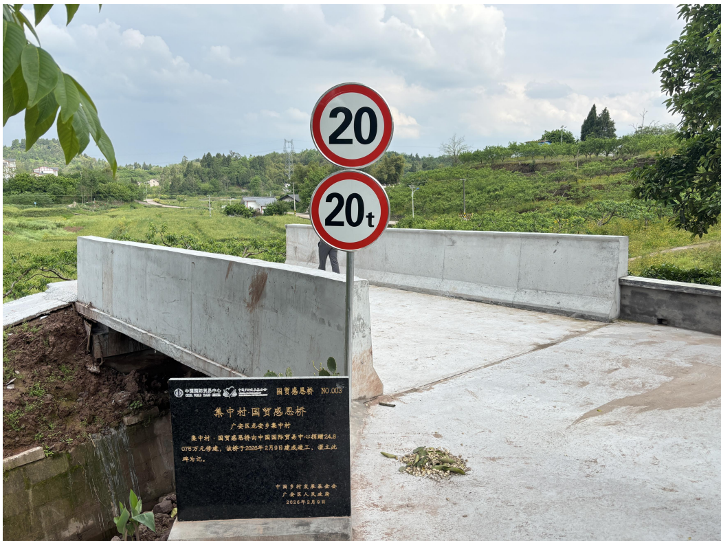
四川省广安区龙安乡集中村国贸感恩桥建设完工现场照片
