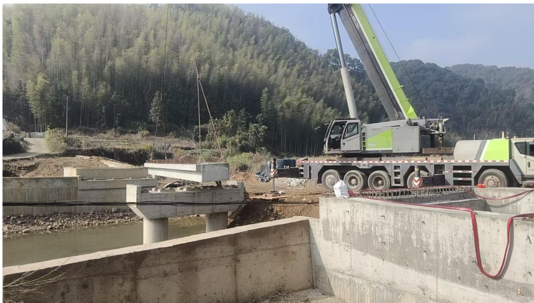
江西省资溪县石峡乡彭田村圳上桥施工现场照片
