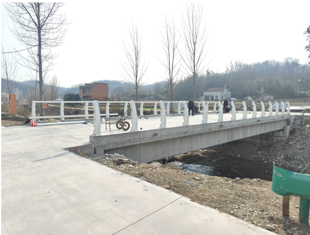
湖北省随县洪山镇黄家畈小畈平桥施工现场照片
