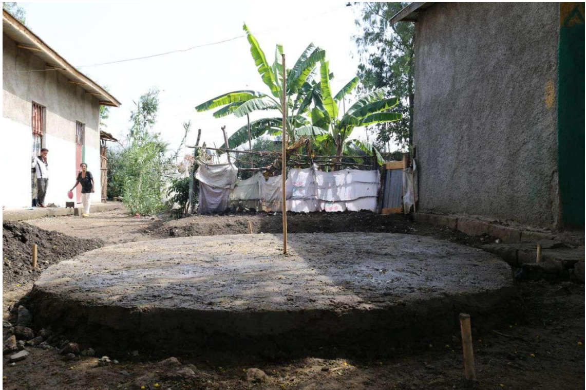
埃塞俄比亚水窖项目（第五期）施工现场
