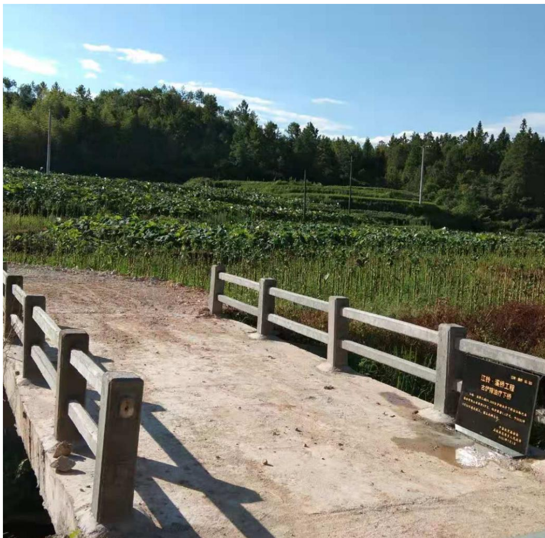
江西省石城县县水庙村柏下桥竣工全貌
