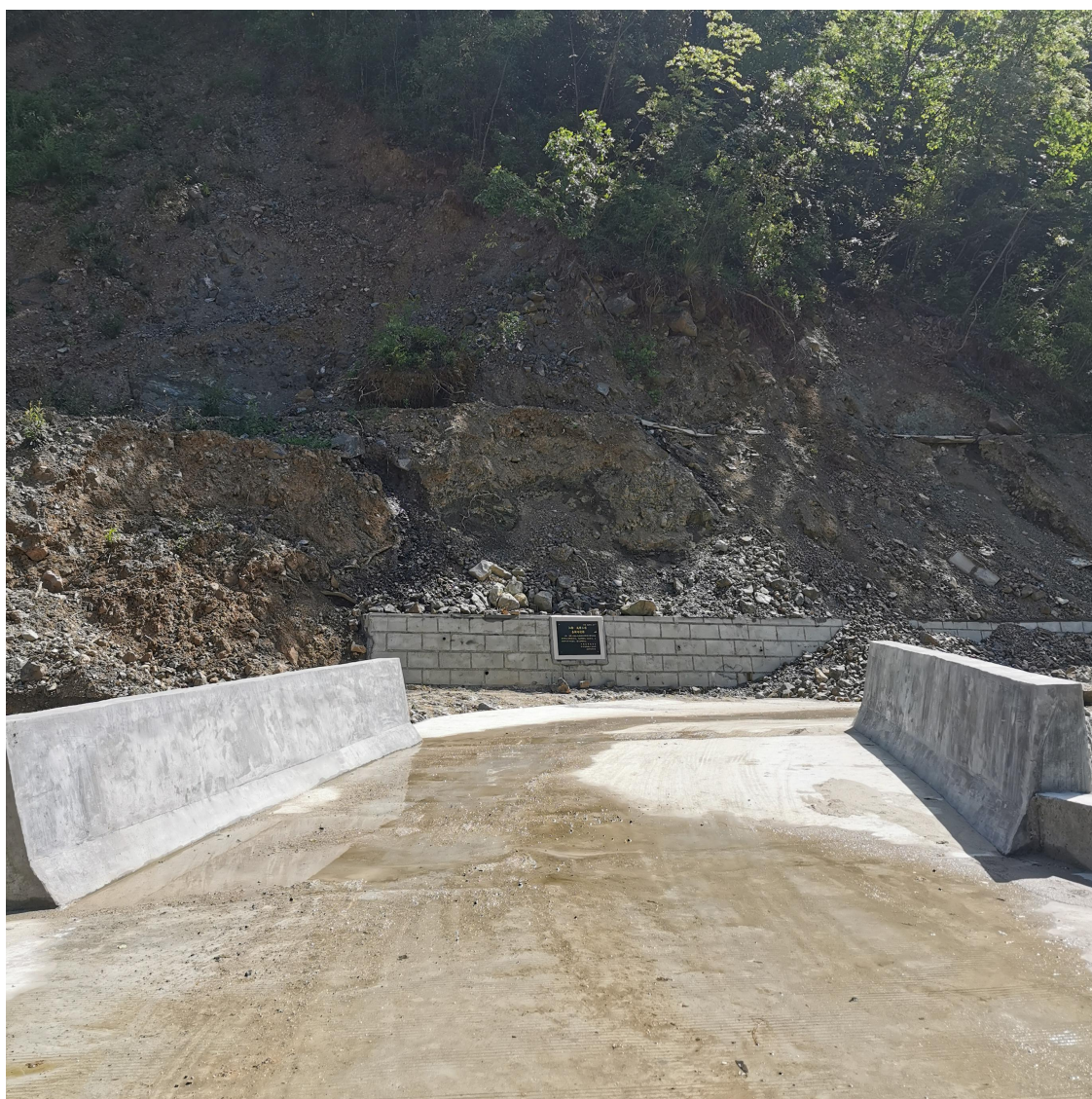
陕西省洋县便民桥竣工全貌
