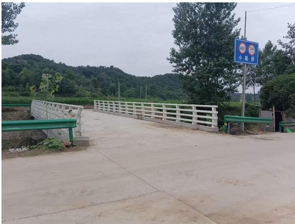
湖北省随县洪山镇黄家畈小畈平桥建设完工现场照片
