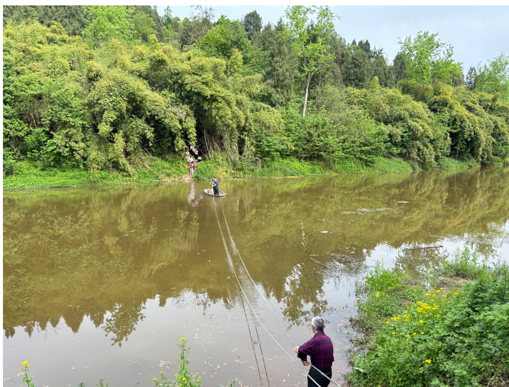
四川省广安市肖溪镇老黄村国贸感恩桥选址调研现场照片
