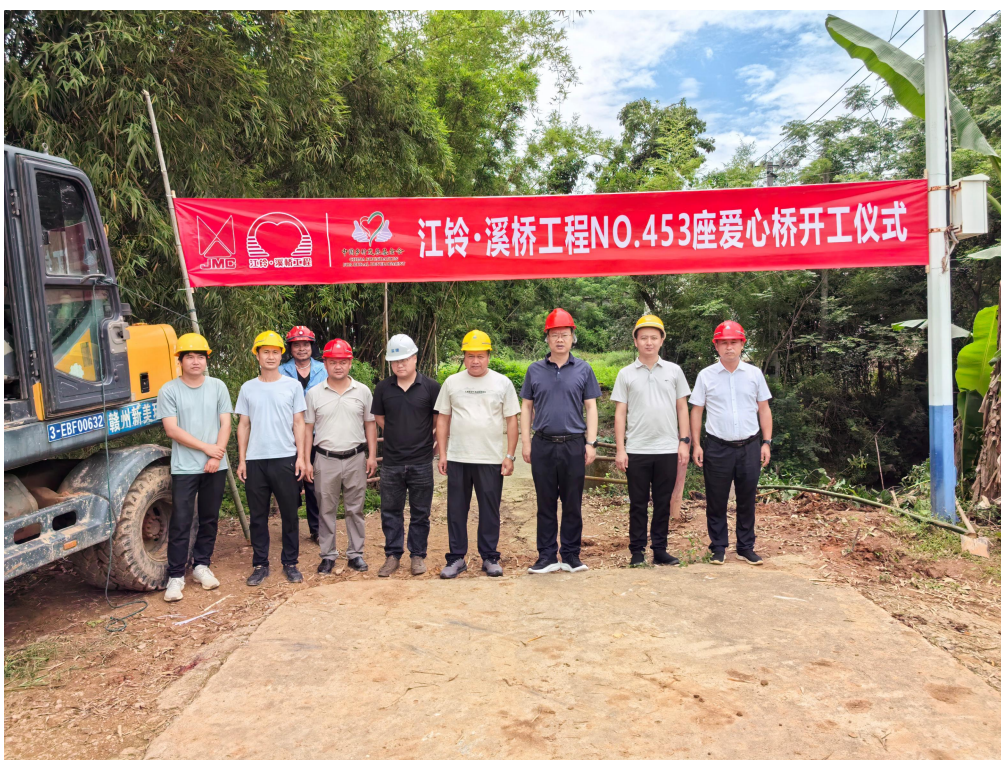
江西省信丰县油山镇下坑仔便民桥开工建设现场照片
