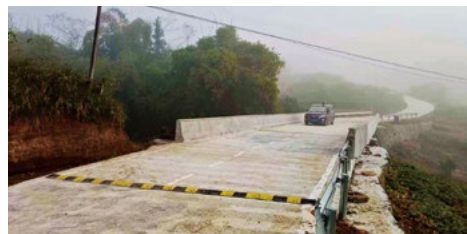
四川省广安区溪桥工程项目建桥通车
