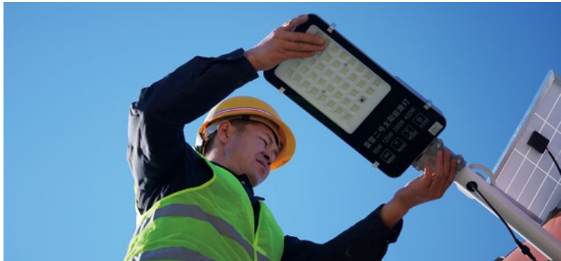
新疆维吾尔自治区尼勒克县施工人员进行太阳能灯安装
