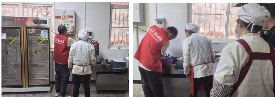
陕西镇安县青铜关镇梅花小学安装爱心厨房设备
