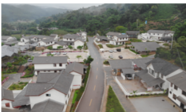
村组道路改造后
