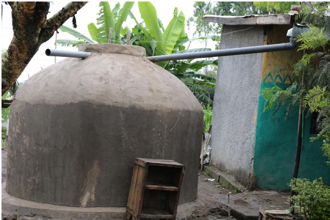
接通屋顶投入使用
