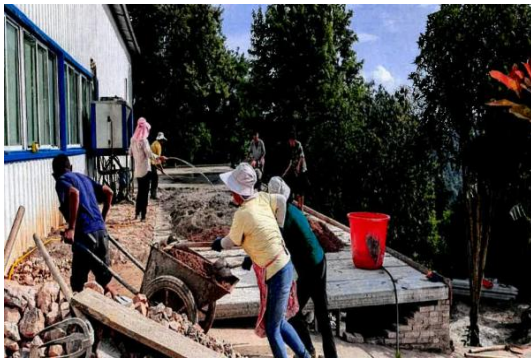
富民车间在项目资金支持下进行厂房更新
