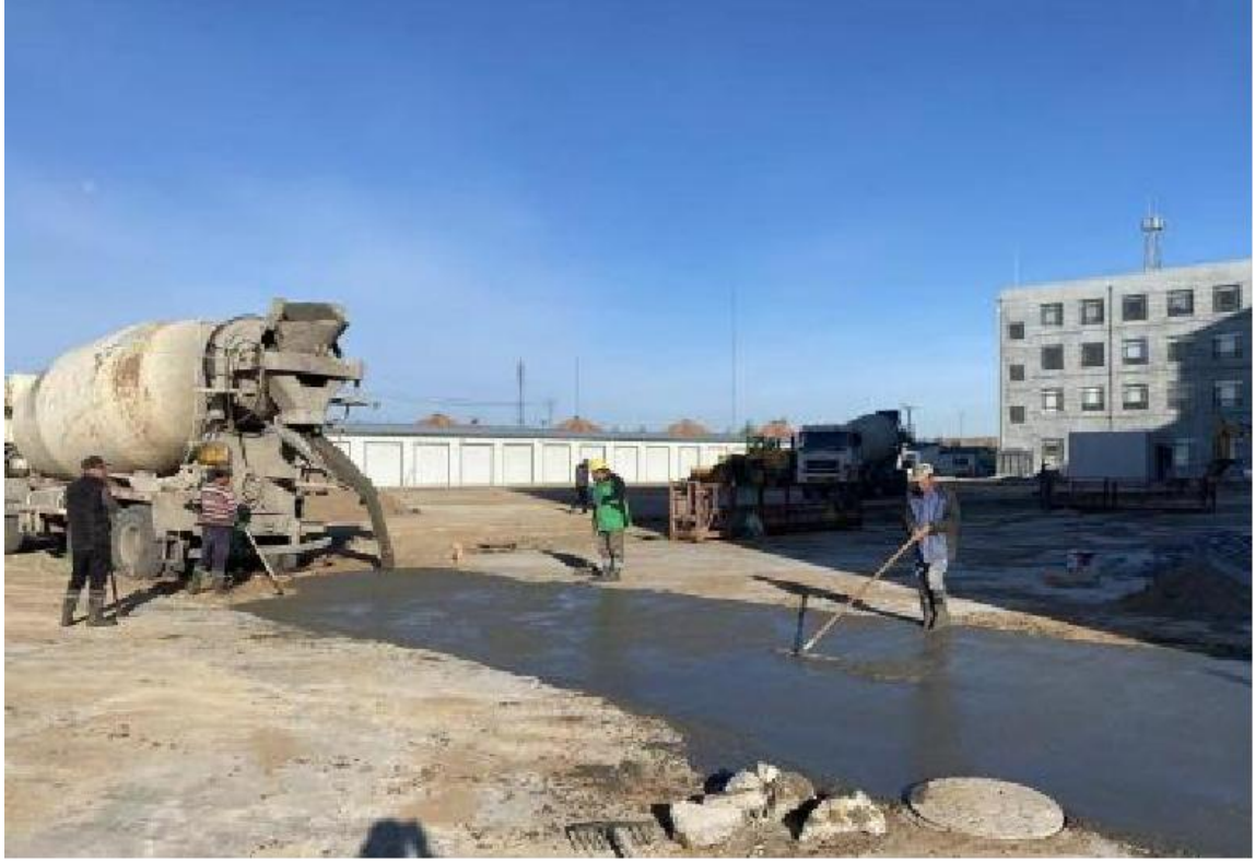
多伦县第一小学跑道硬化施工照片
