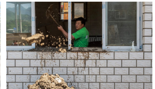
重振家园 - 以工代赈（房屋恢复清理）
