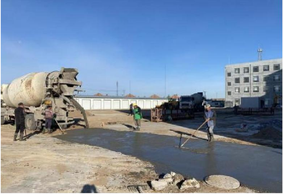
多伦县第一小学跑道硬化施工照片
