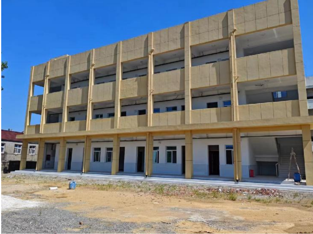
麦元初级中学校舍主体竣工照片
