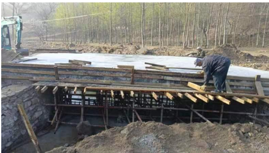
涑水县龙门乡的上港村桥开工
