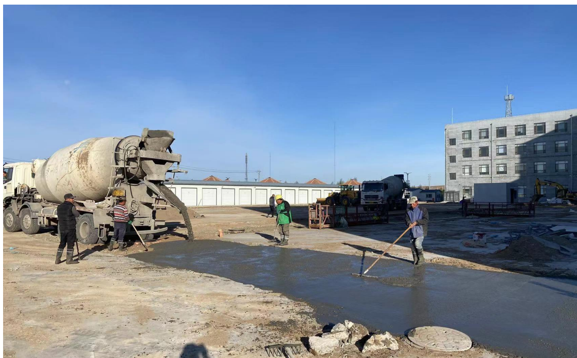
多伦县第一小学场地水泥浇筑
