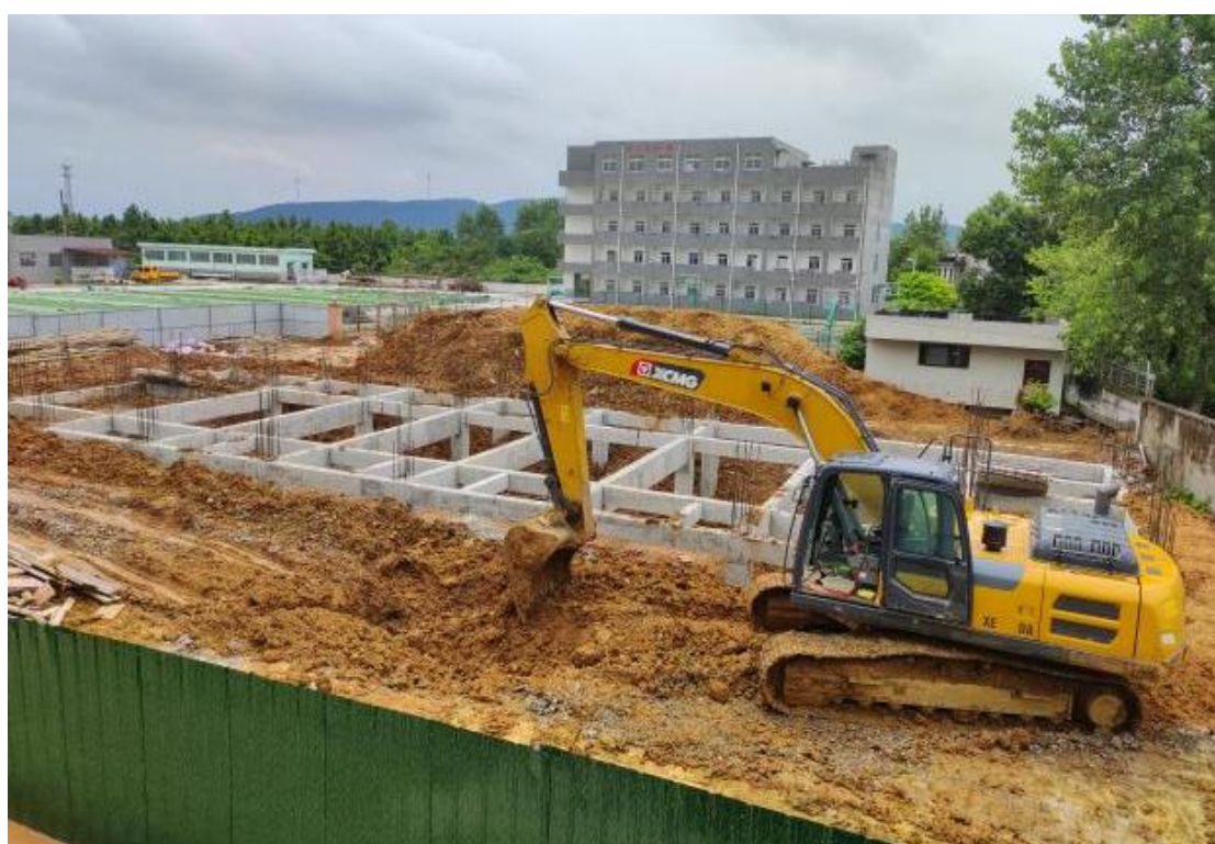
麦元初级中学校舍土方回填
