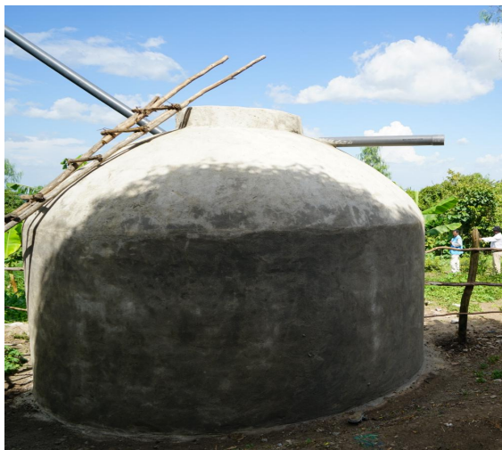
▲已投入使用的水窖（待完成粉刷）
