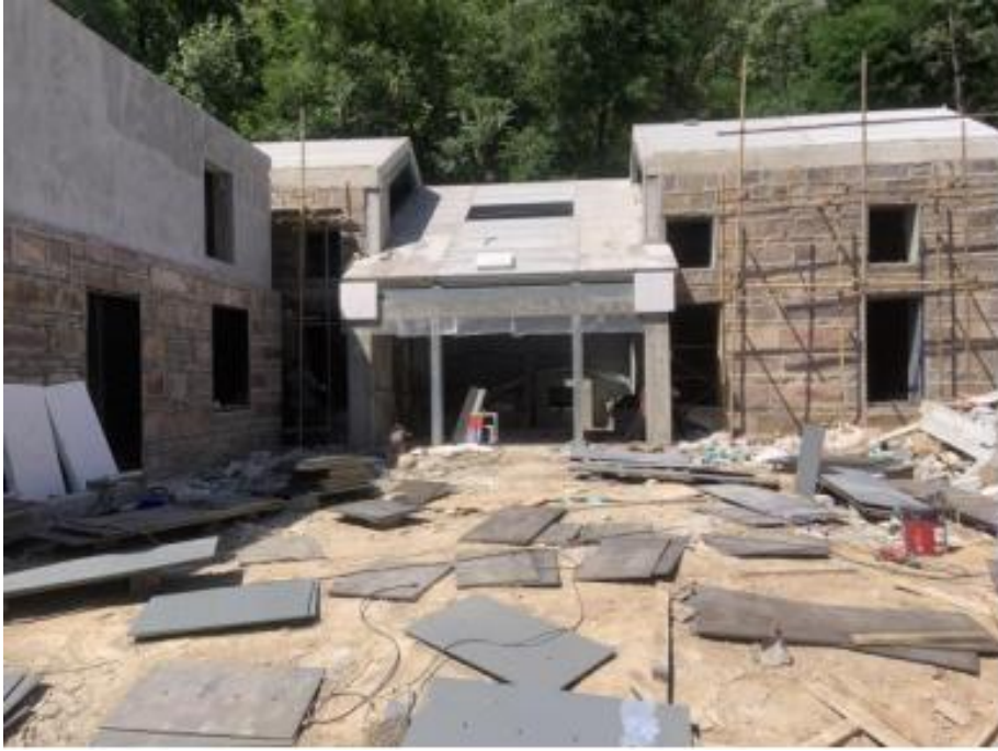
民宿硬装建设中
