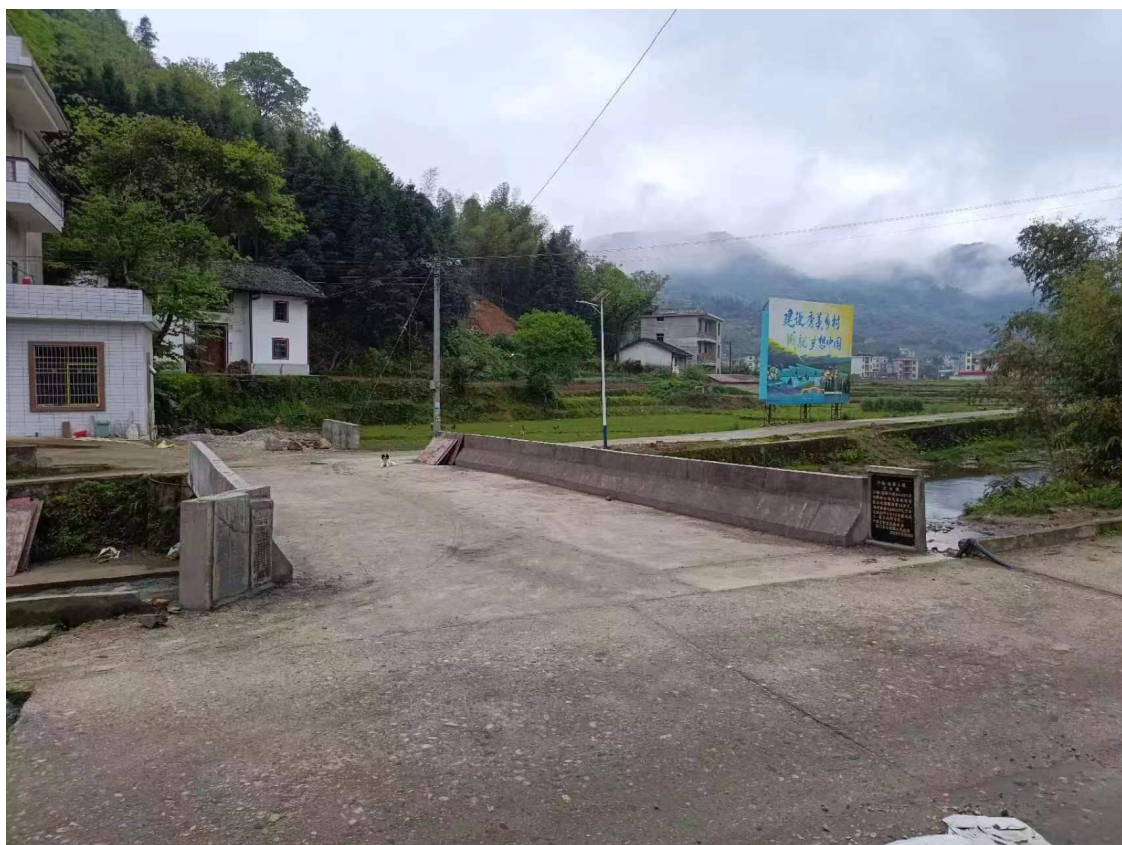
江西省遂川县大汾镇方头桥竣工照片
