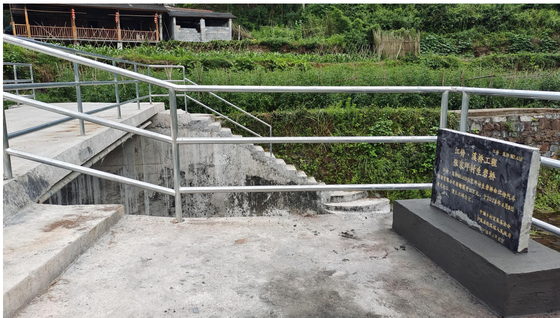
湖南省泸溪县洗溪镇张家坪村生岩桥便民桥竣工照片
