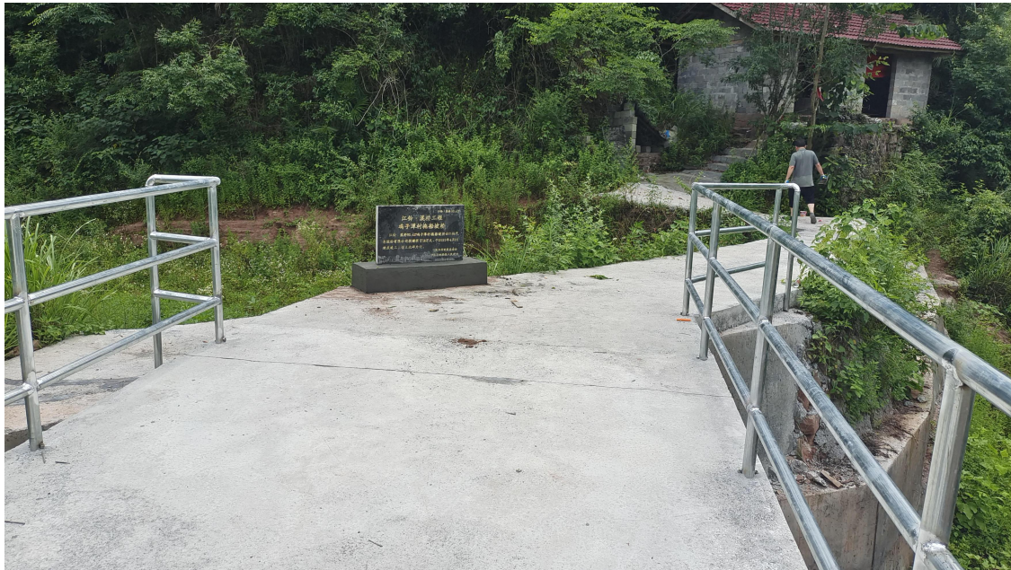
湖南省泸溪县洗溪镇鸡子潭村拖船坡桥便民桥竣工照片
