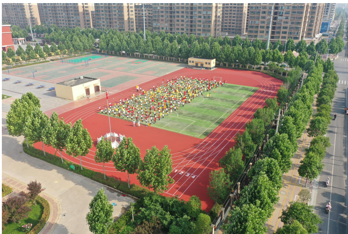
河南省淇县太行小学跑道竣工照片
