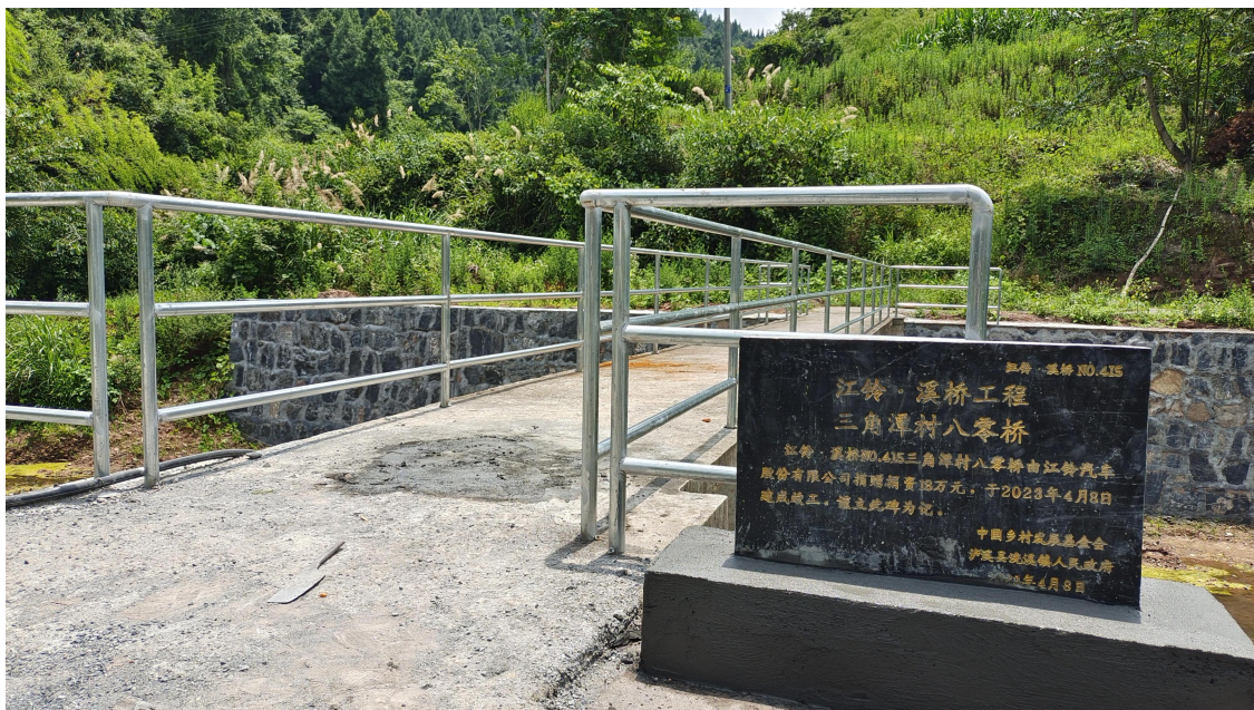
湖南省泸溪县洗溪镇三角潭八零桥便民桥竣工照片
