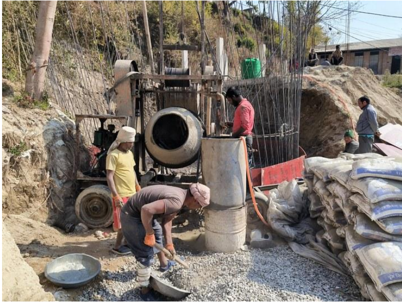
项目施工现场
