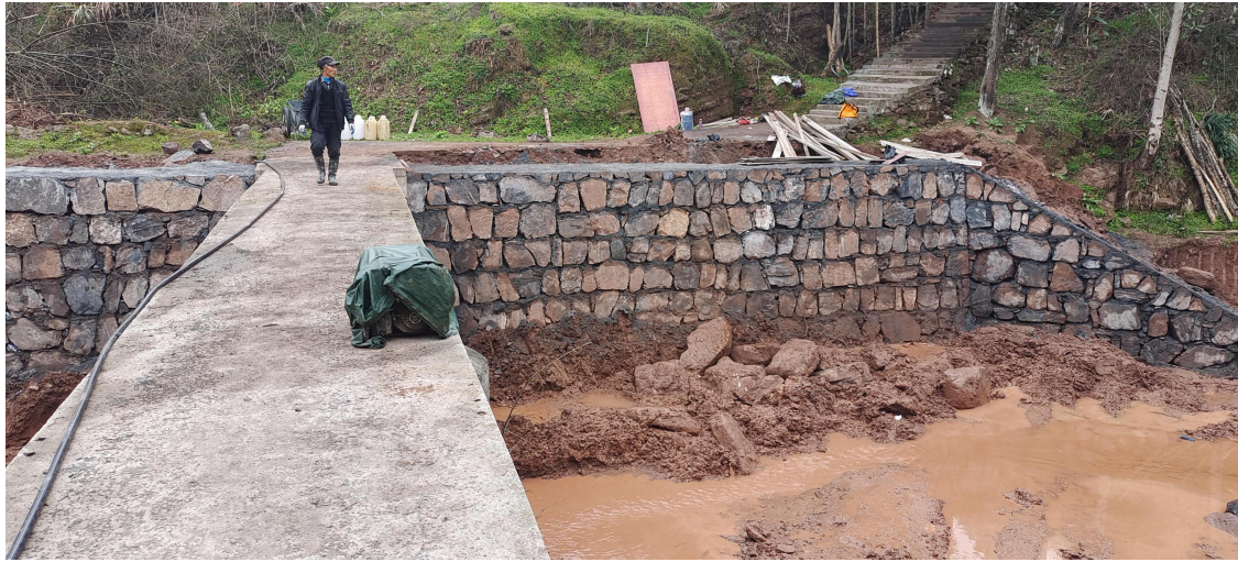
湖南省泸溪县洗溪镇三角潭便民桥施工照片
