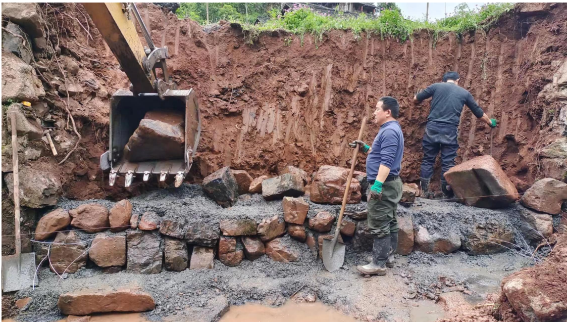
湖南省泸溪县洗溪镇张家坪村便民桥施工照片
