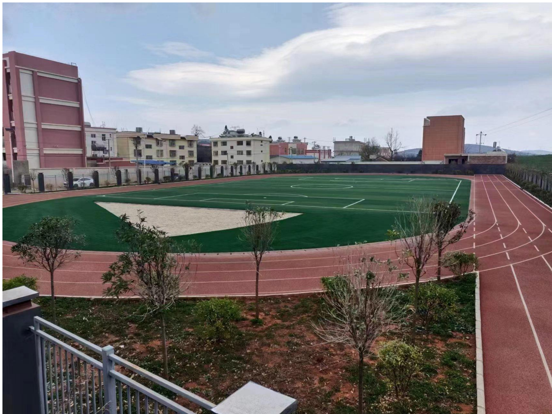
云南省会泽县驾车乡驾车小学跑道竣工照片
