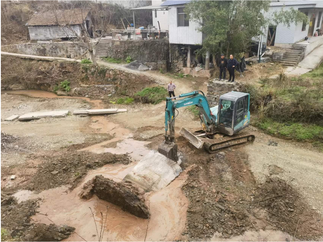
湖南省泸溪县白羊溪乡毛坪村便民桥施工照片
