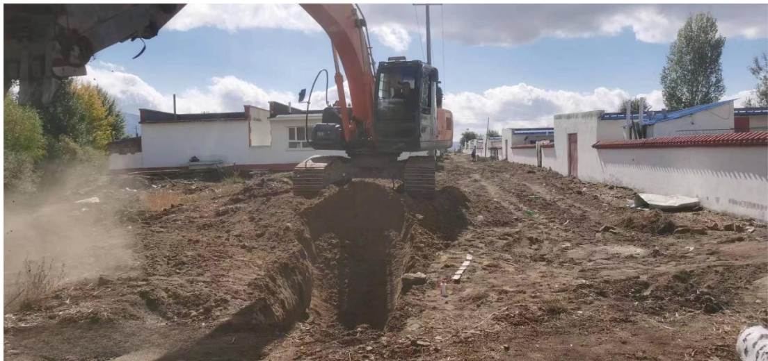
青河县施工照片
