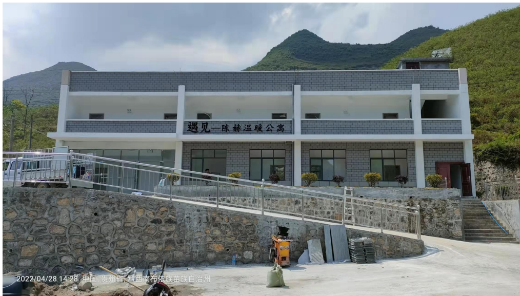
(人才公寓主体建设完成图)
