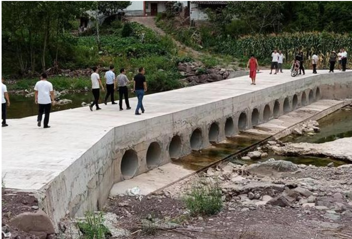
南江县东坝村陈家沟爱心桥竣工
