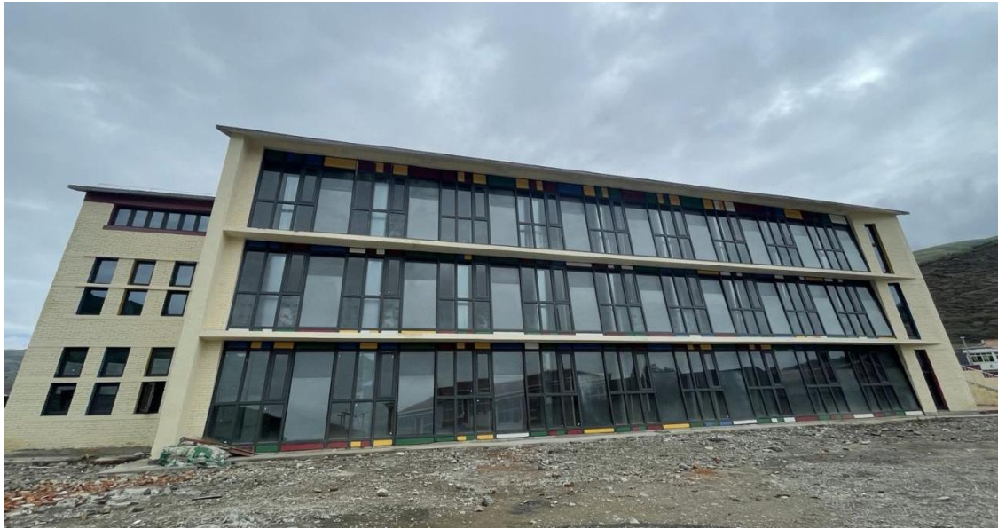
四川省阿坝县安羌乡中心校竣工照片 1
