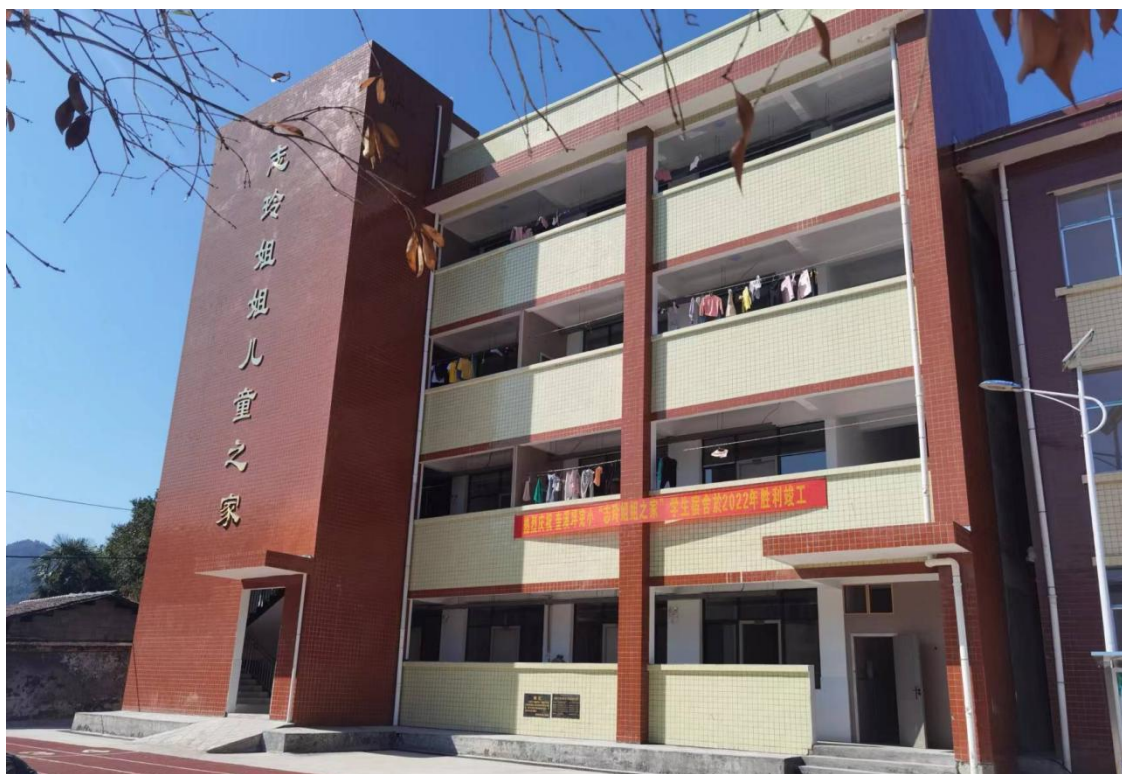
湖南省安化县奎溪坪完小竣工照片 1
