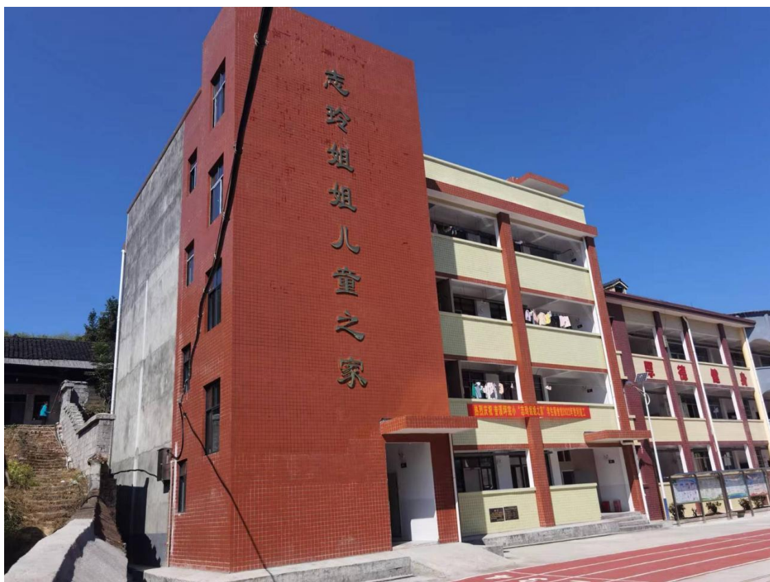
湖南省安化县奎溪坪完小竣工照片 2
