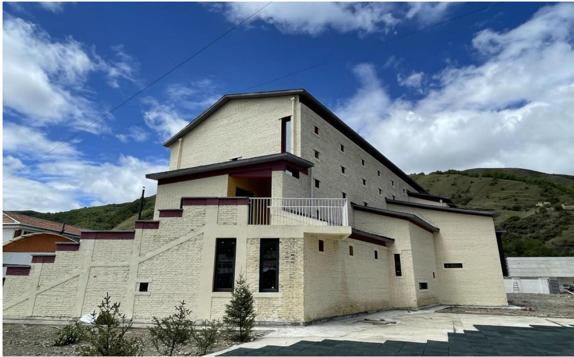
四川省阿坝县安羌乡中心校竣工照片 2
