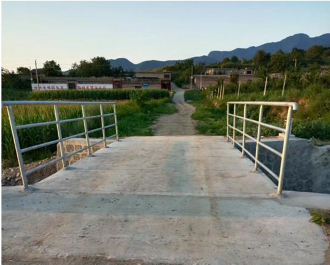
山西省霍州市南车腰村爱心桥竣工
