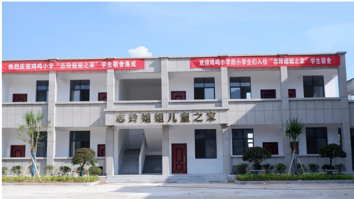
湖北省罗田县鸡鸣山小学竣工照片
