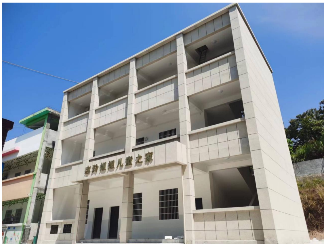
湖北省罗田县许家畈小学竣工照片
