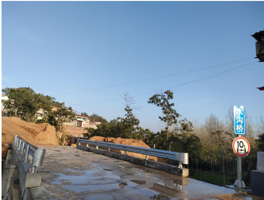
巩义市米河镇高庙村水沟桥竣工照片
