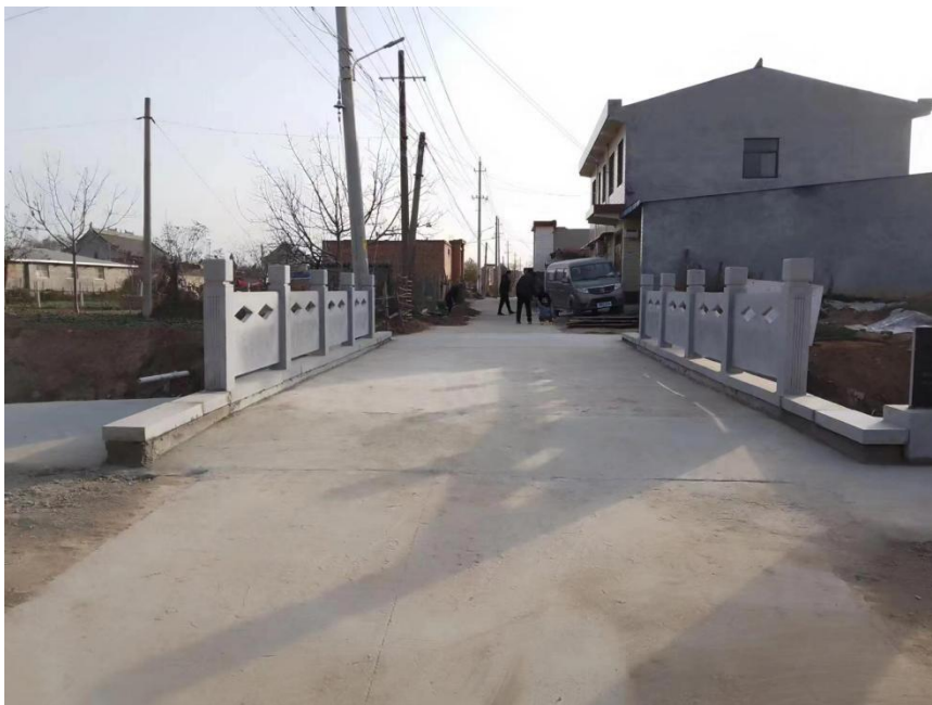
洛阳市偃师区邙岭镇牛庄村连心桥竣工照片
