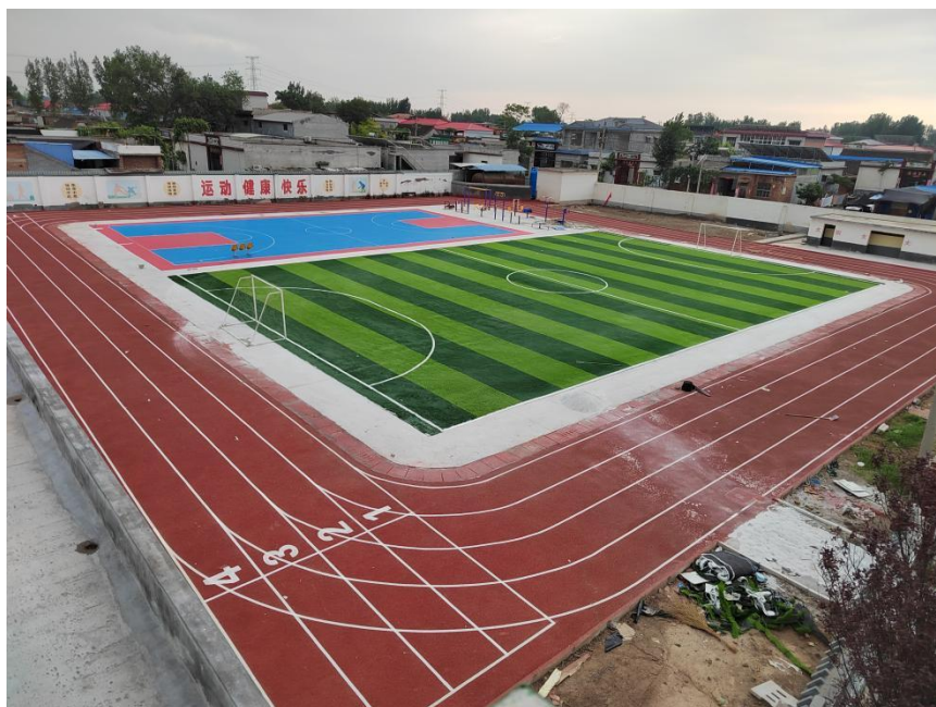
辉县市吴村镇落安营学校竣工照片
