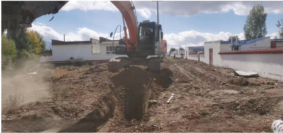
青河县施工照片
