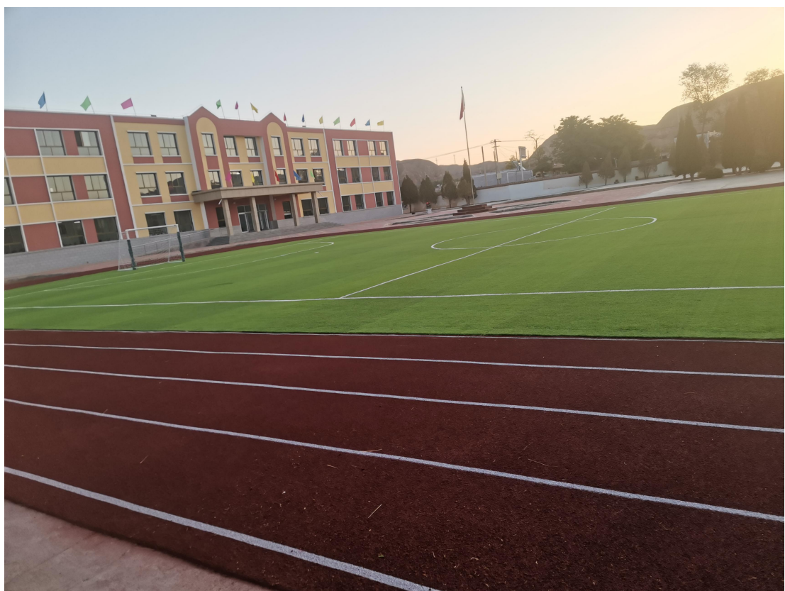
甘肃省靖远县砂梁贝壳爱心小学竣工
