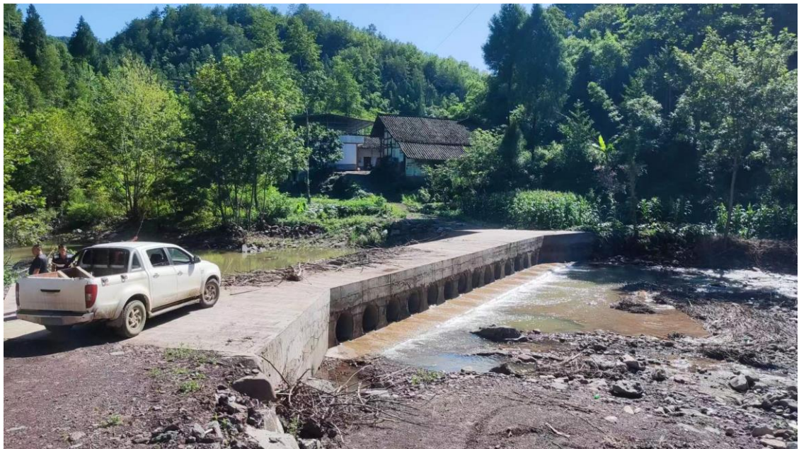
四川省南江县关路镇东坝村陈家沟爱心桥竣工
