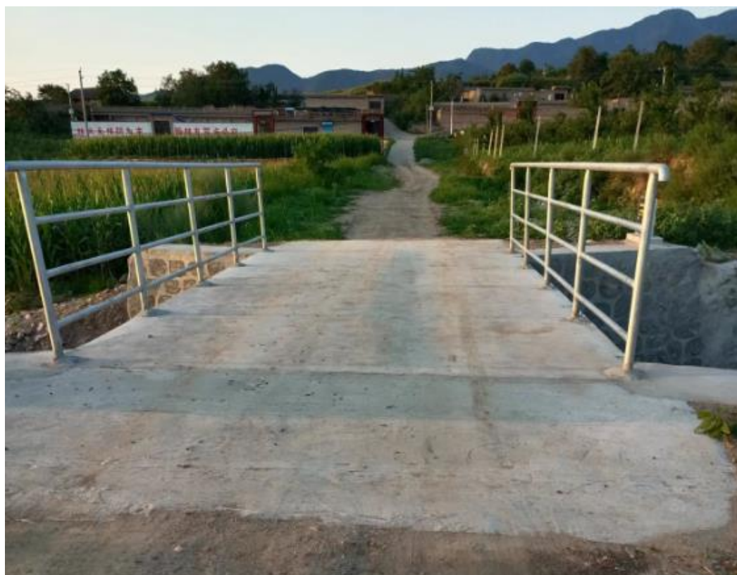
山西省霍州市南车腰爱心桥竣工
