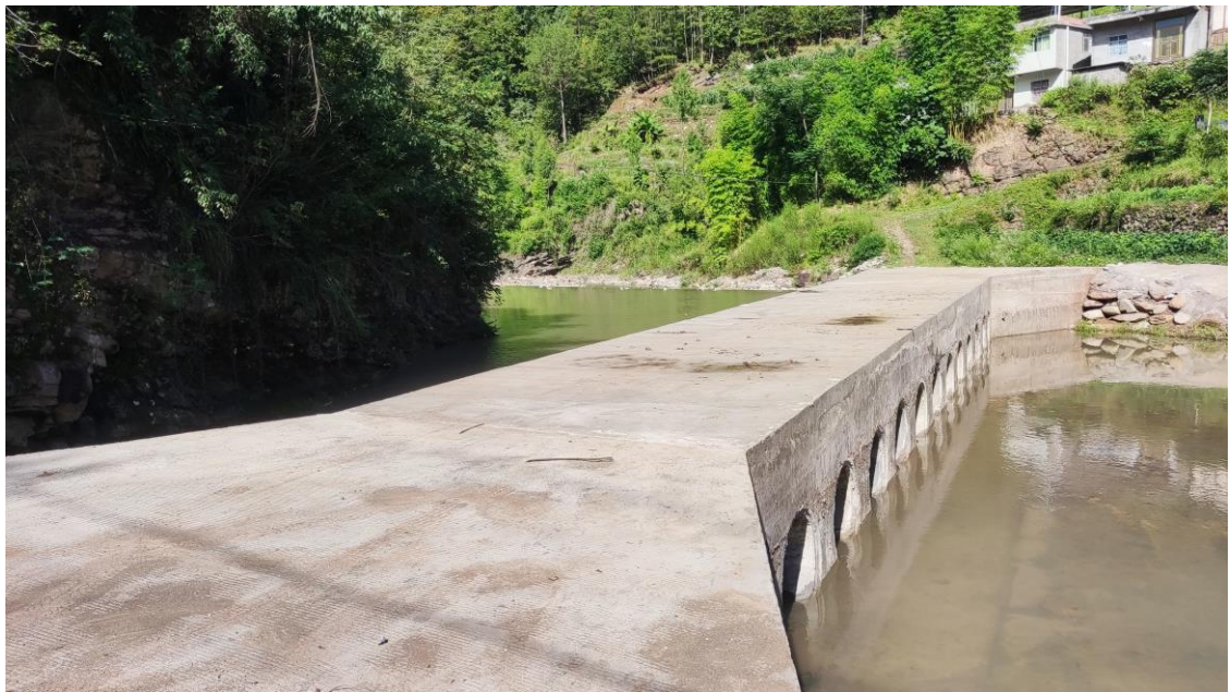
四川省南江县关路镇西坪村后河里爱心桥竣工
