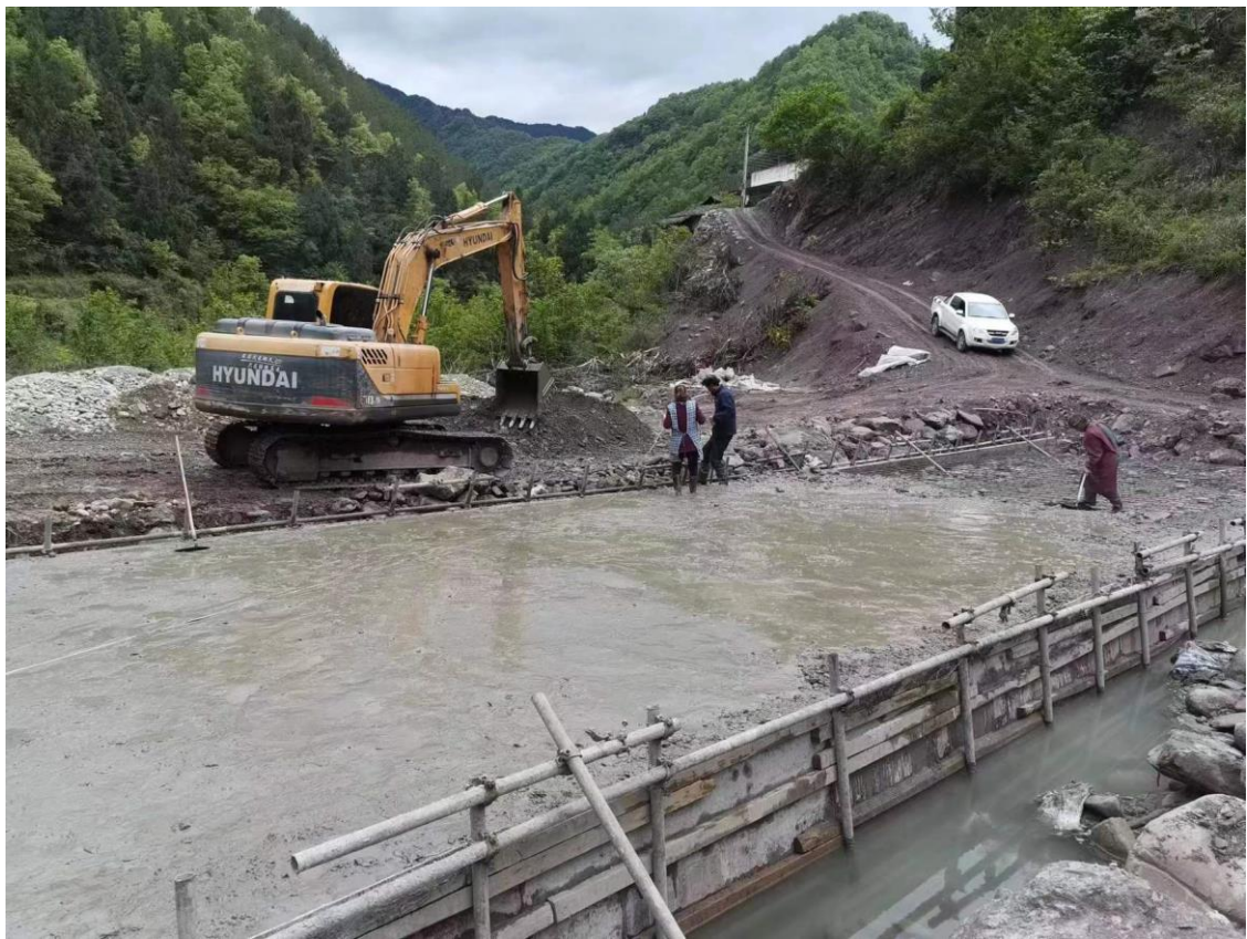
四川省南江县便民桥施工
