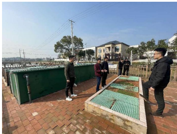
项目团队在湖南浏阳了解污水治理工程
