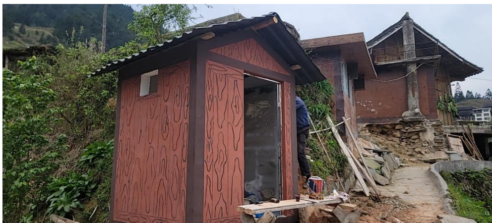
白岩村样板厕所基本建设完成
