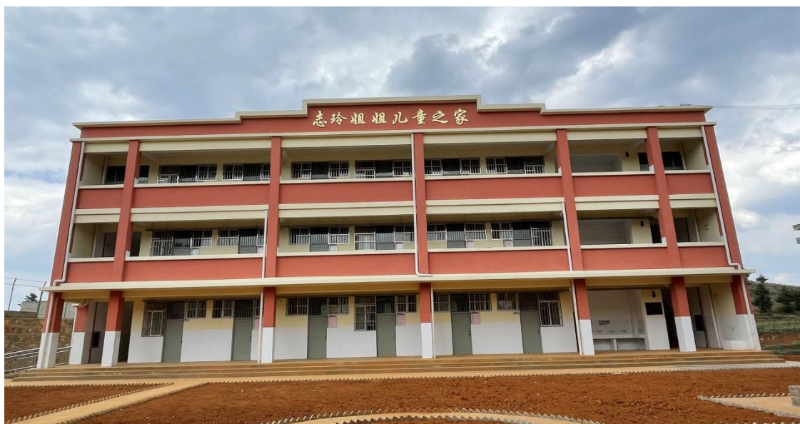
奋斗小学竣工
