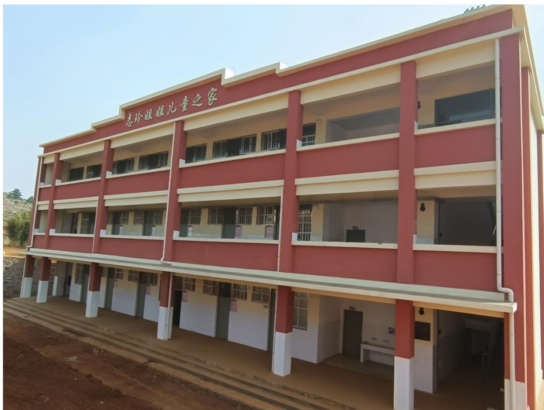
云南省会泽县奋斗小学碑记、楼名已安装完毕
