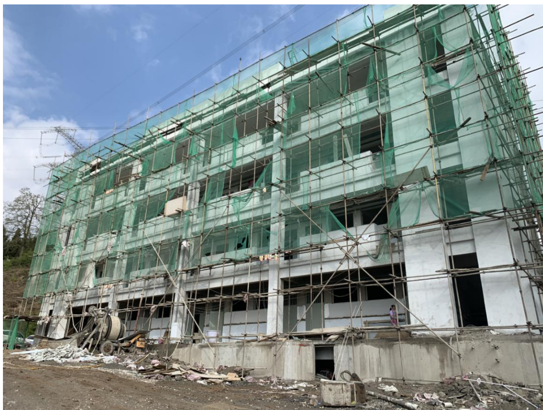
云南省会泽县奋斗小学外墙粉饰中
