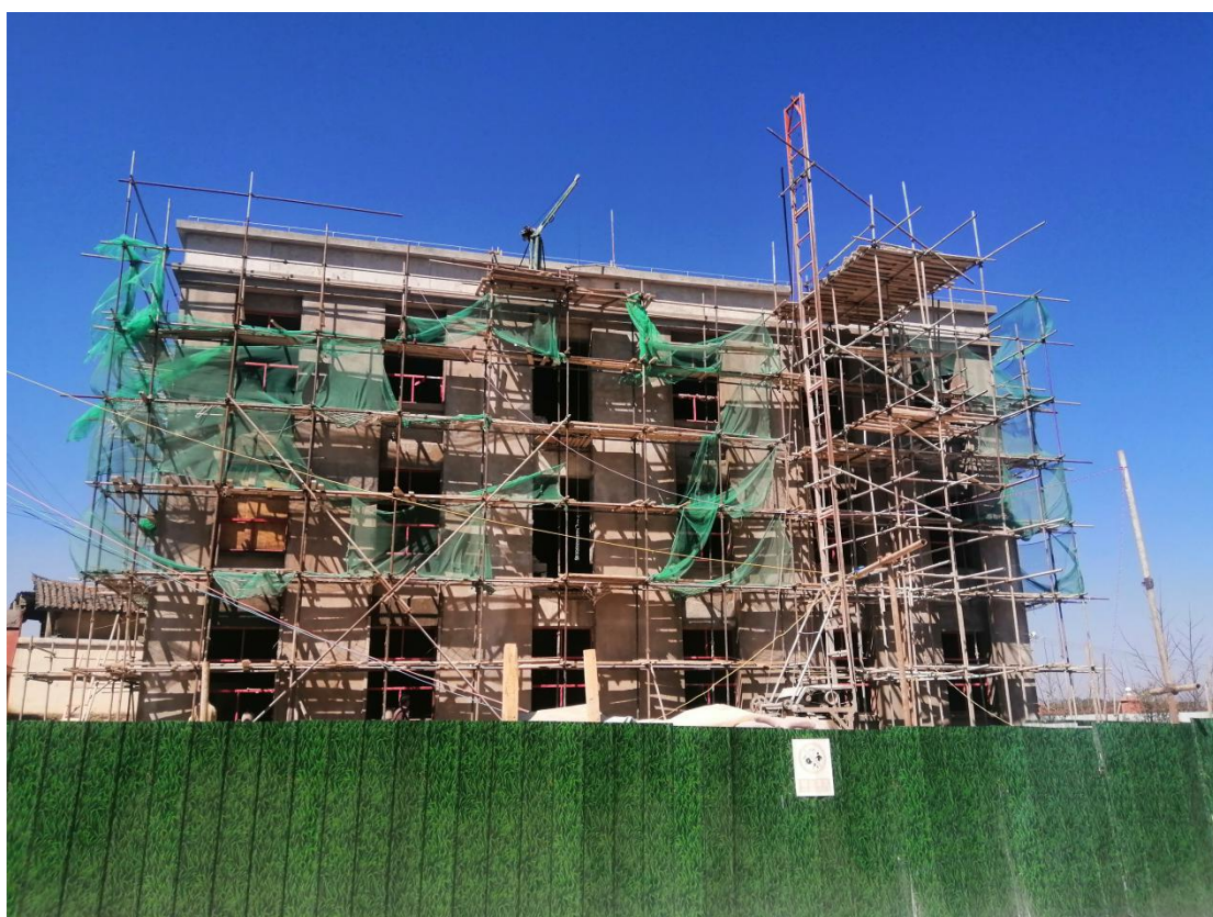
云南省会泽县纸厂小学内部装修等装饰工程
