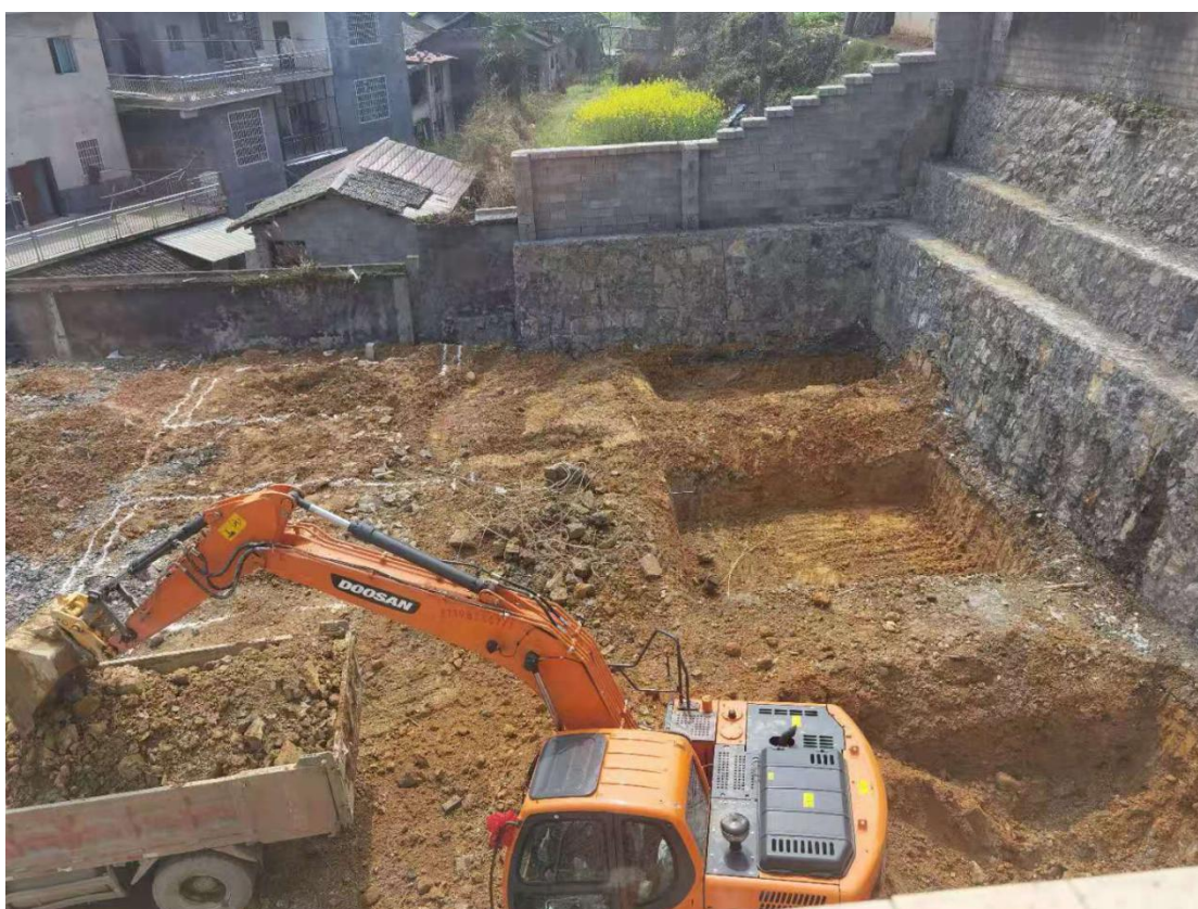
湖南省安化县奎溪坪完小施工进场，基础开挖
