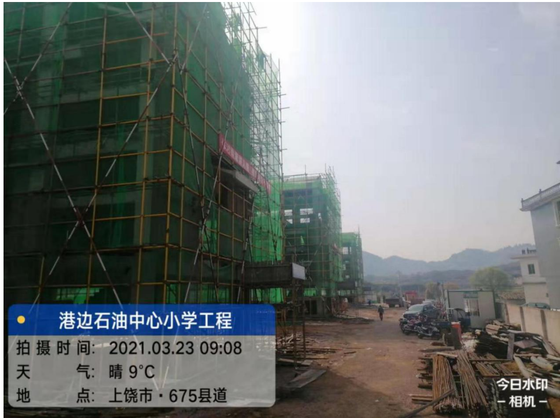
横峰县港边石油中心小学项目室内墙抹灰及装饰装修，三楼楼板建设中
