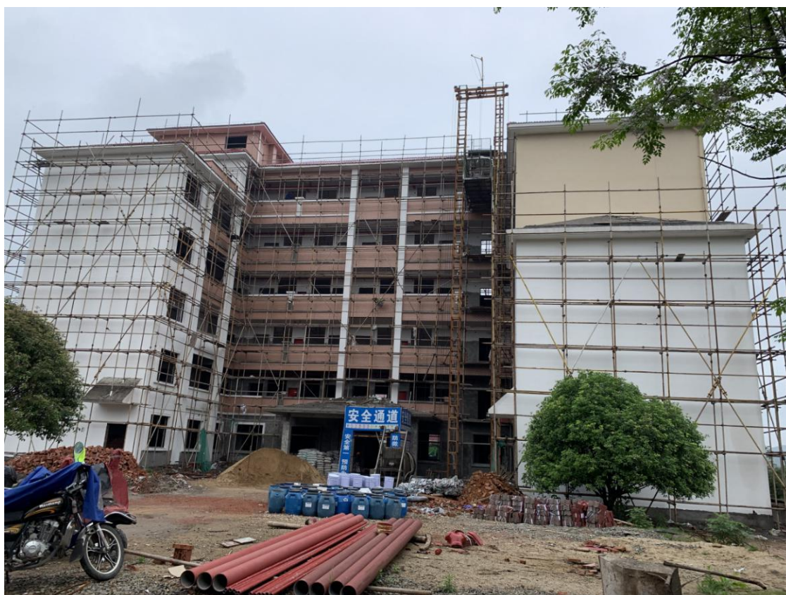
遂川县泉江镇中心养老院院民服务大楼综合楼建设项目内部装修中
