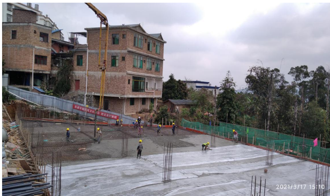
麻栗坡县六河中学建设照片
