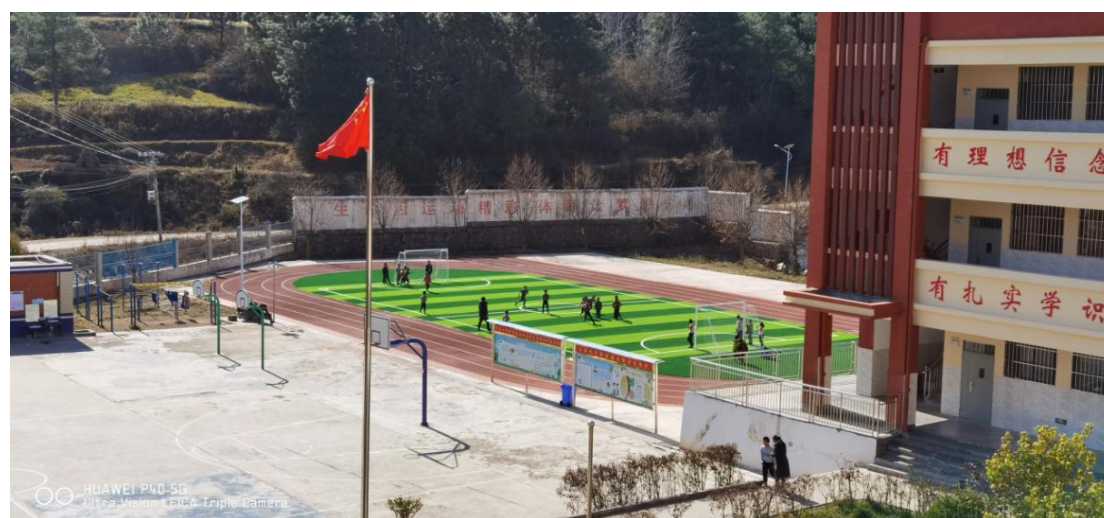
会泽县卡龙小学建设照片
