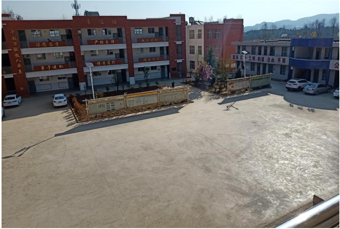
会泽县赵家村小学建设照片
