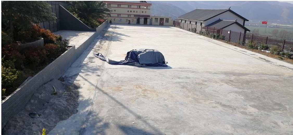
会泽县白雾小学建设照片
