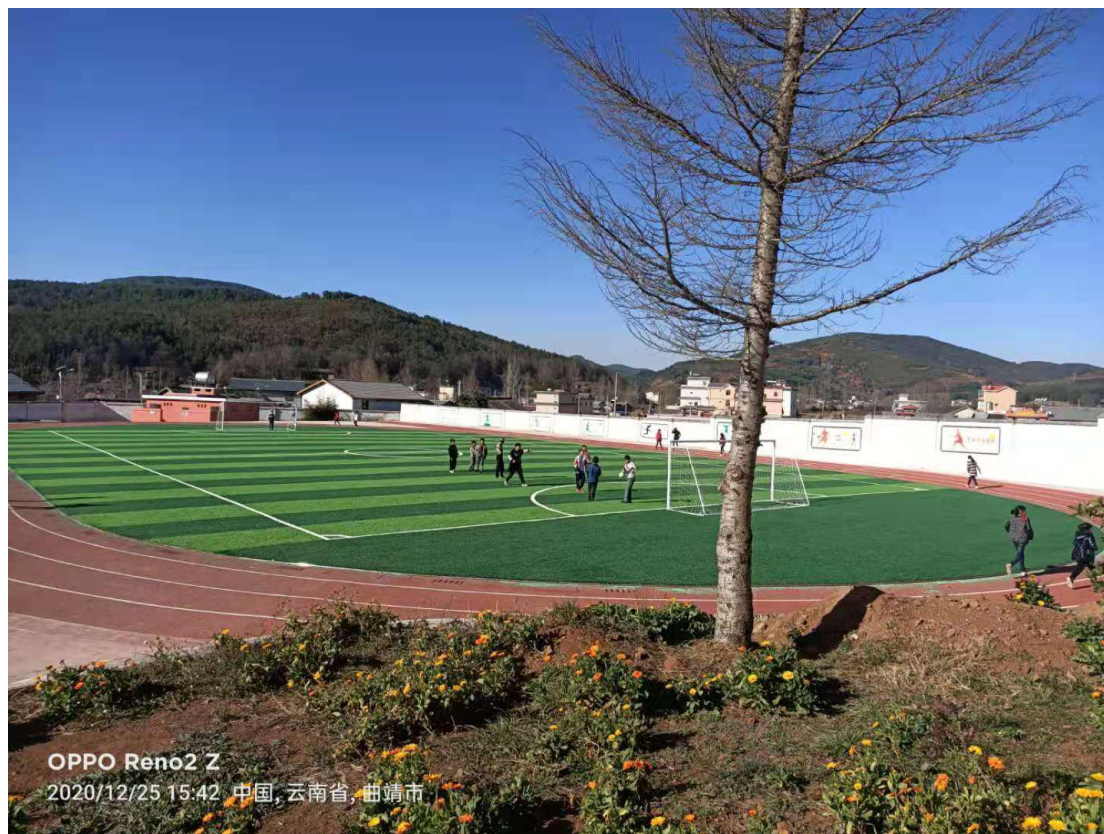
会泽县马店小学建设完成照片
