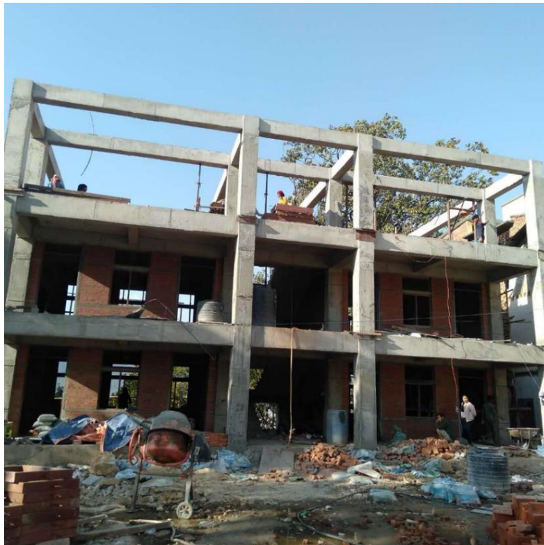
尼泊尔 ANANDA KUTI 学校教学楼主体工程建设完成
