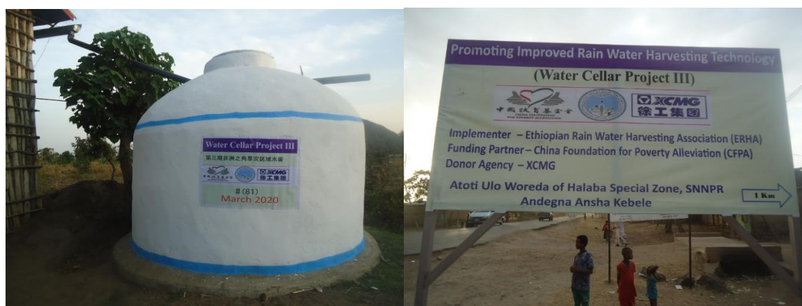
粉刷完毕的水窖外观及项目指引标牌
