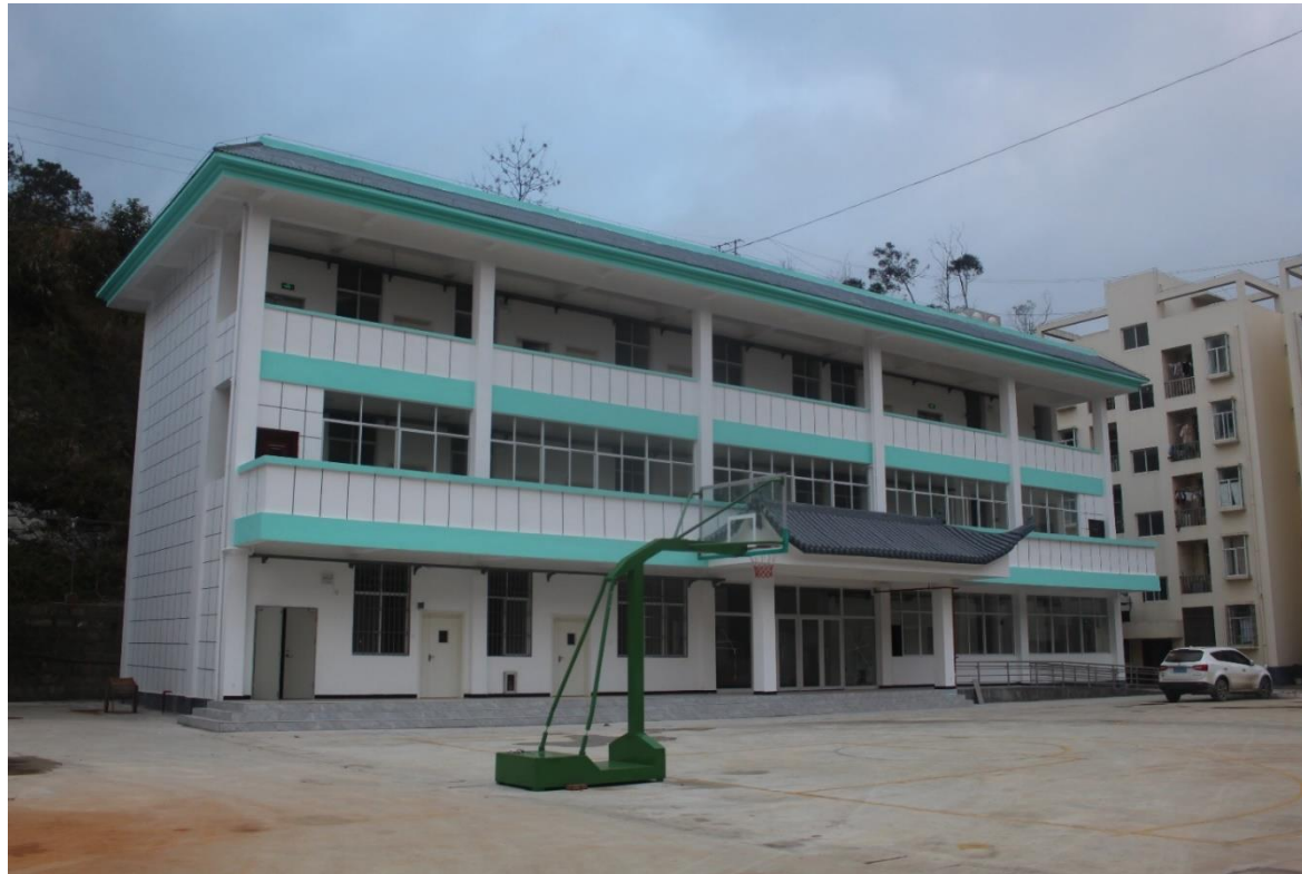
麻栗坡县杨万卫生院项目主体竣工照片
