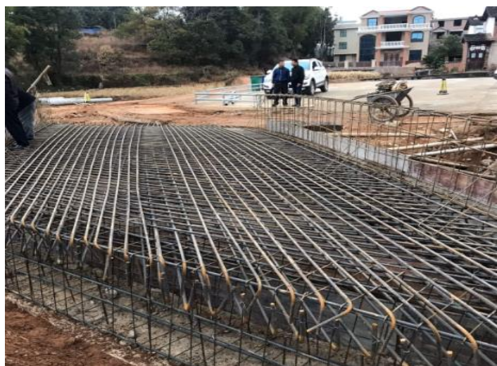
NO.369 大众组桥
