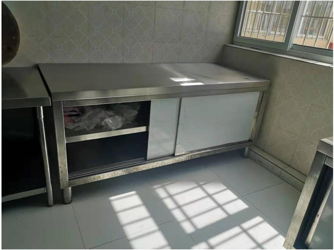
甘孜县第二幼儿园厨房完成改造照片
