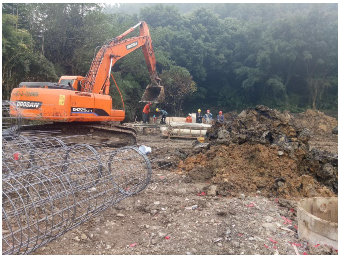
钢筋笼子加工
