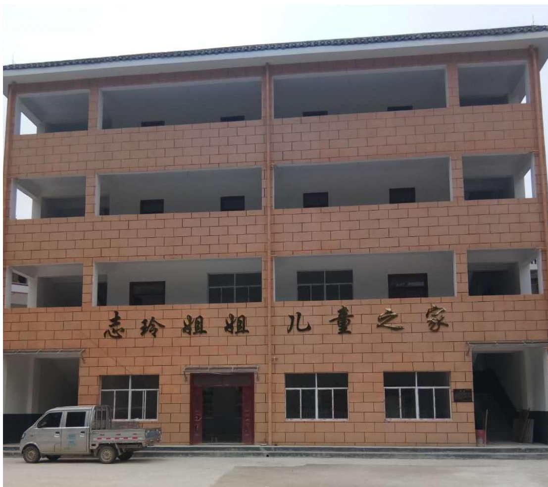
黎平小学筑巢行动项目竣工
