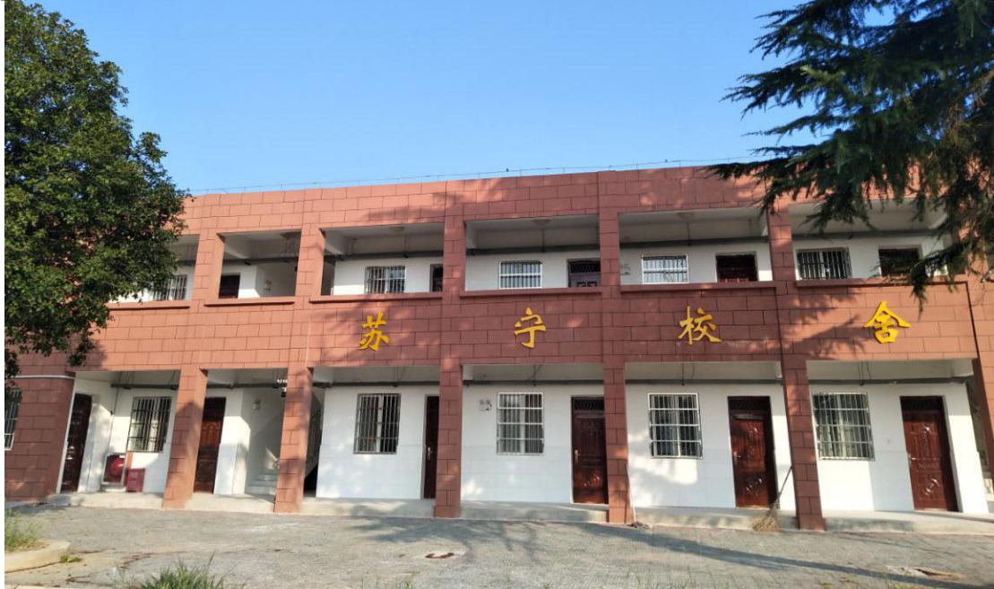
中洲小学筑巢行动项目竣工
