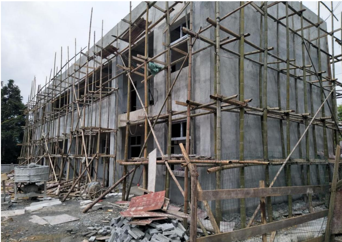
从江县东勤小学主体完工，内墙砌筑中
