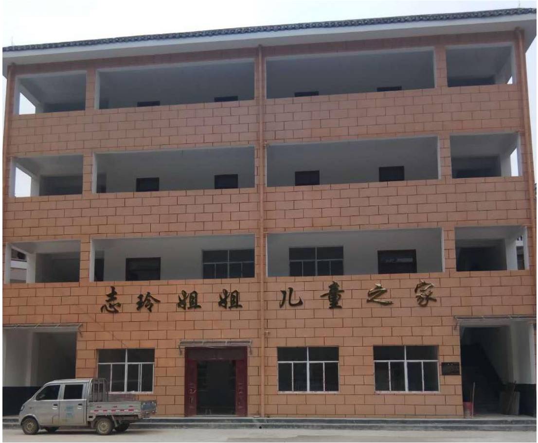
黎平县高求小学筑巢已竣工
