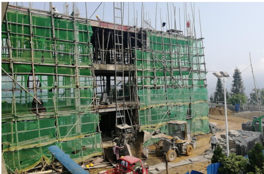
从江县归奶小学四层支柱砌筑中
