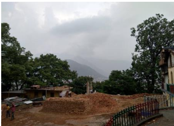
旧教学楼拆除后
