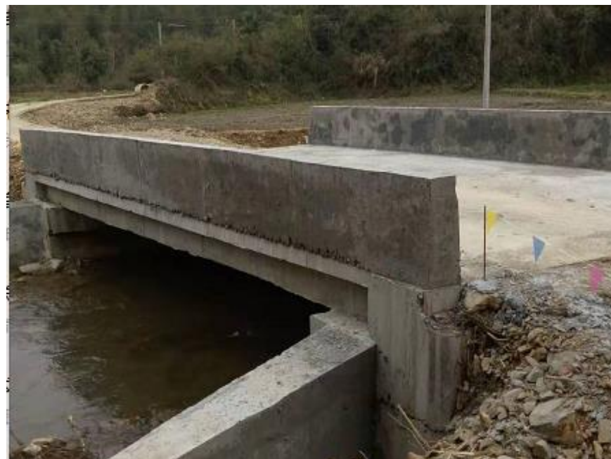
NO. 345 大背桥（竣工）
