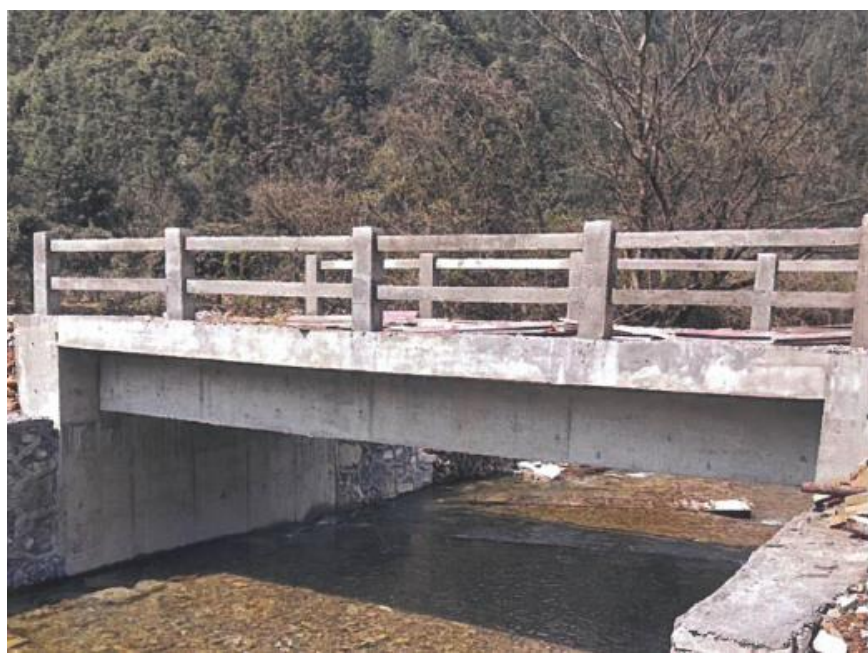
NO. 323 里坑口便民桥（竣工）
