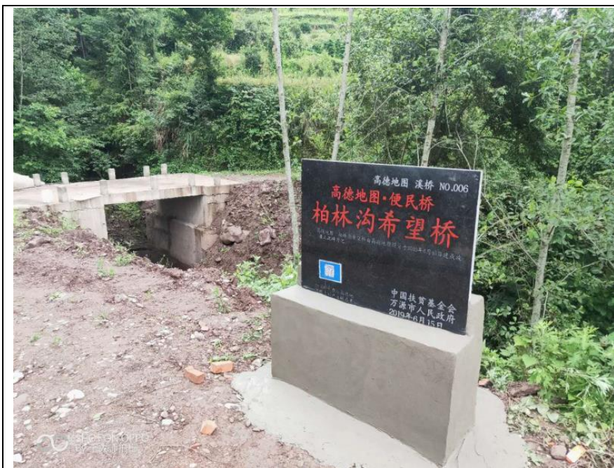
柏林沟希望桥（竣工）
