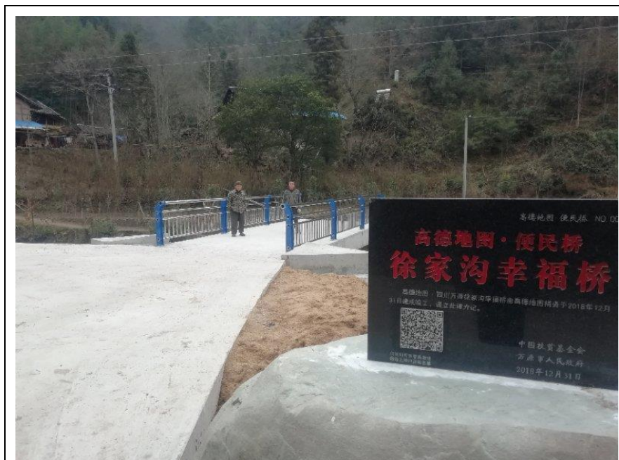
徐家沟幸福桥（竣工）
