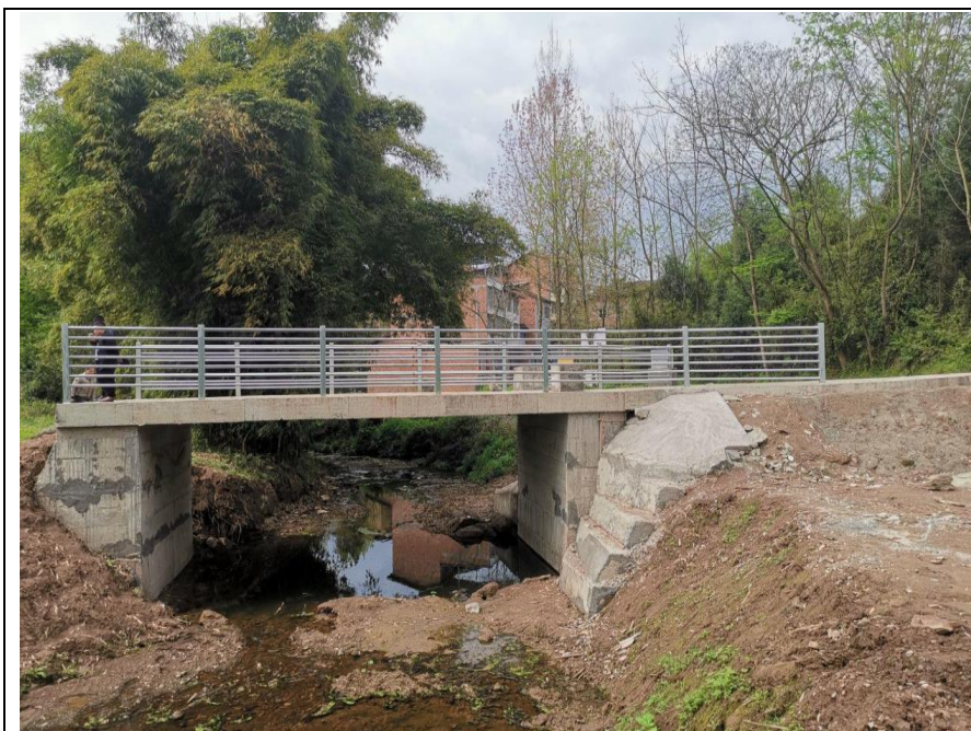
NO.035 牟家河便民桥 (竣工)
