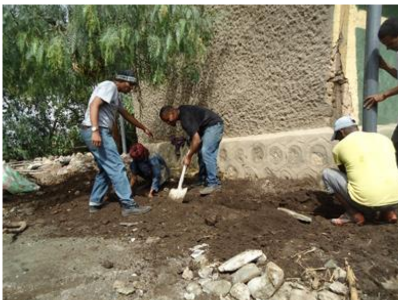
水窖施工现场
