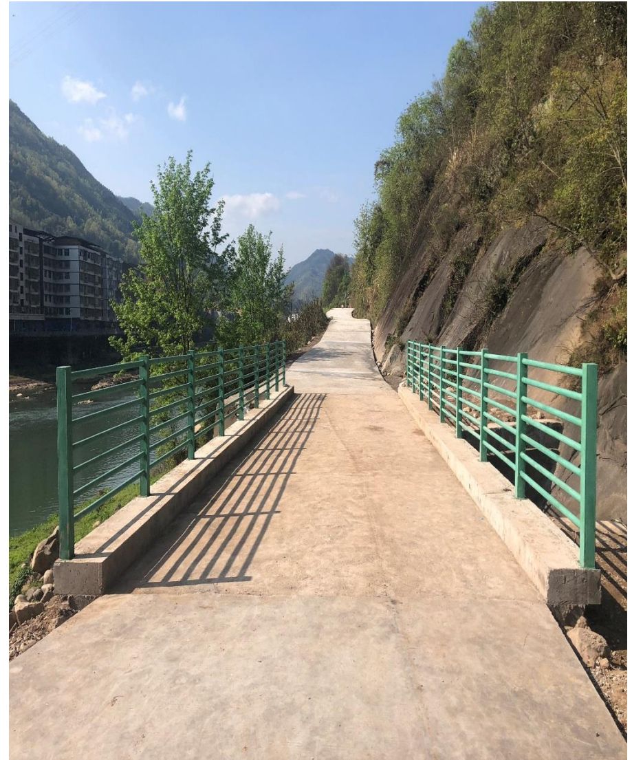
NO.347 严家河便民桥（竣工）
