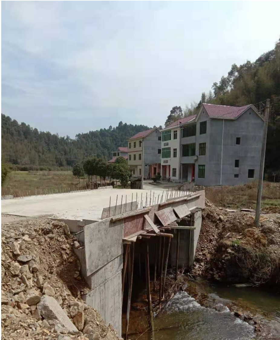
NO.343 陂下桥（竣工）
