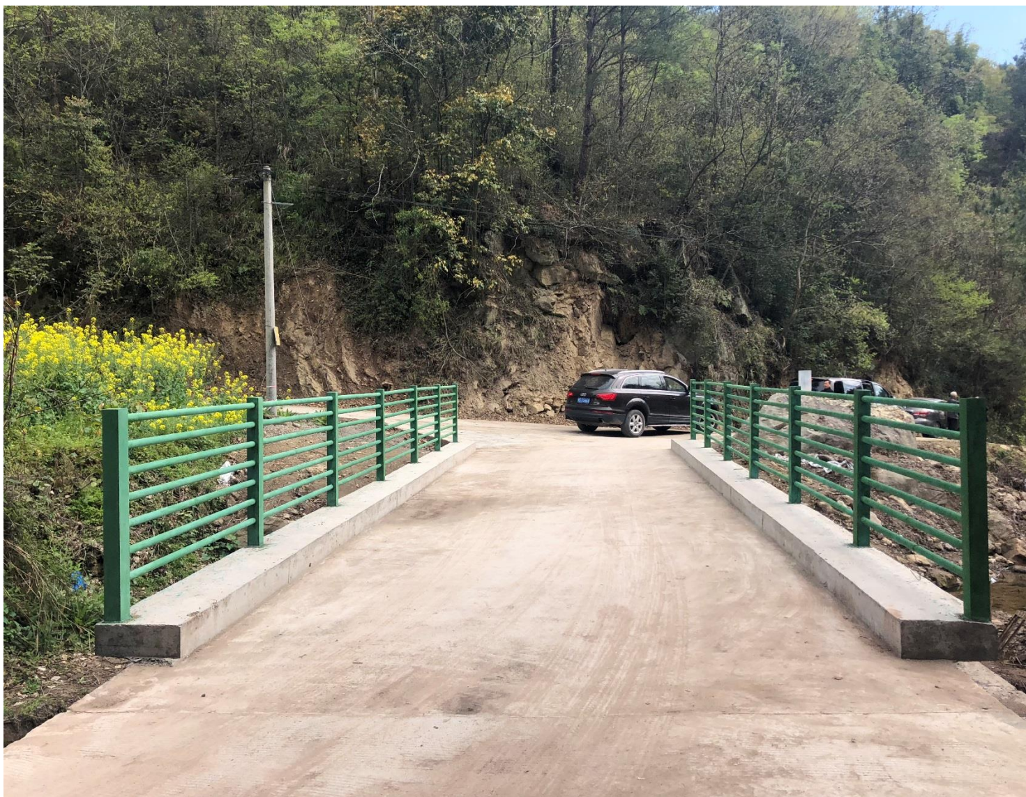
NO.265 贾口村便民桥（竣工）
