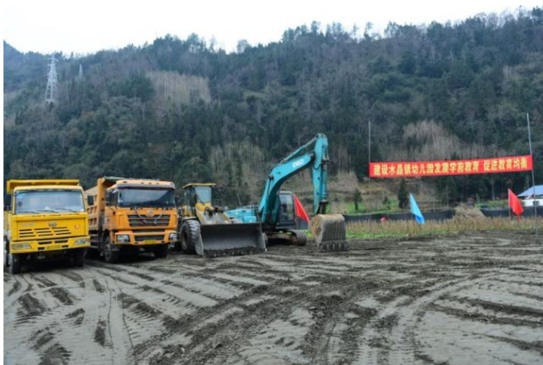
图5 平武县水晶幼儿园新建项目开工仪式现场
