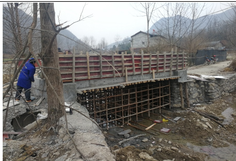
杜家院便民桥
