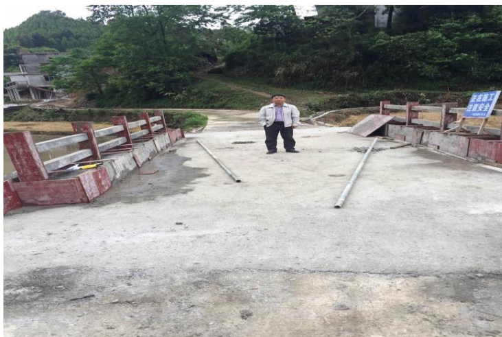
NO.284 遛肥屯桥 (已竣工)
