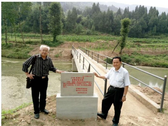
NO.276 余家河漫水桥 (已竣工)
