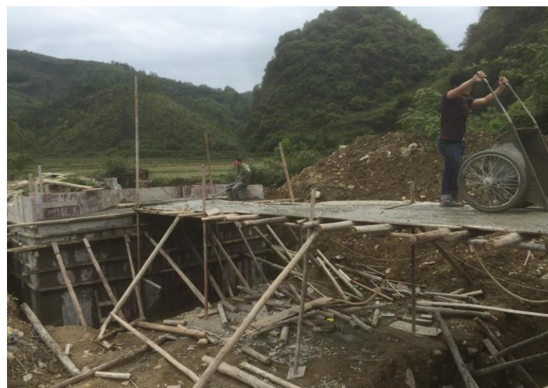
NO.287 利浪屯桥 (已竣工)
