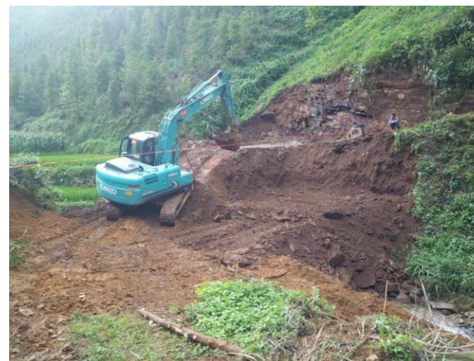
NO.020 瑶人沟桥 (在建)
