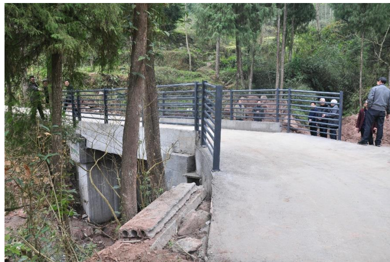
NO.277 桐籽园小桥 (已竣工)
