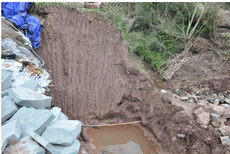
NO.278 水洞连心桥 (在建)
