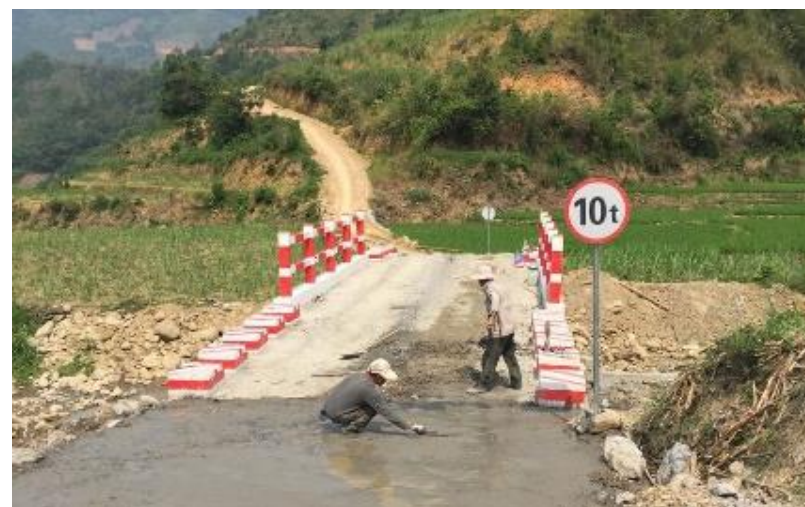
NO.006 渭坝桥 (已竣工)
