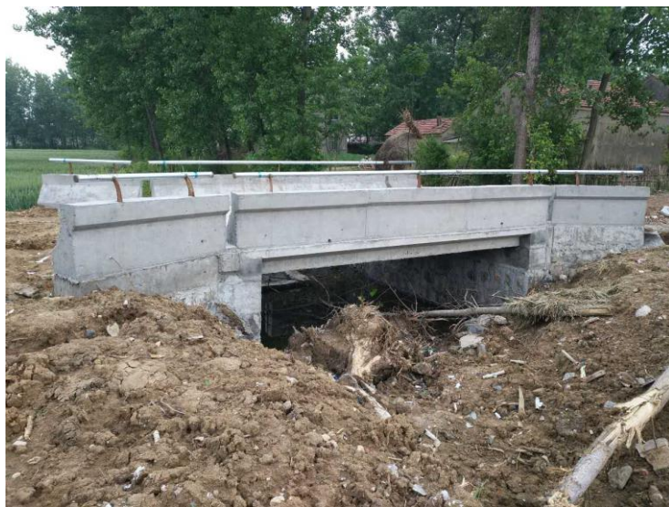
NO.298 小鲍庄桥 (已竣工)
