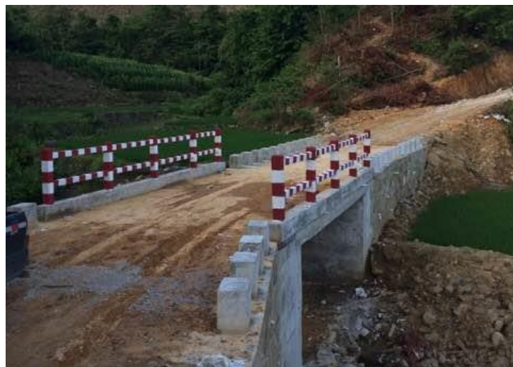
NO.007 平赖桥 (已竣工)
