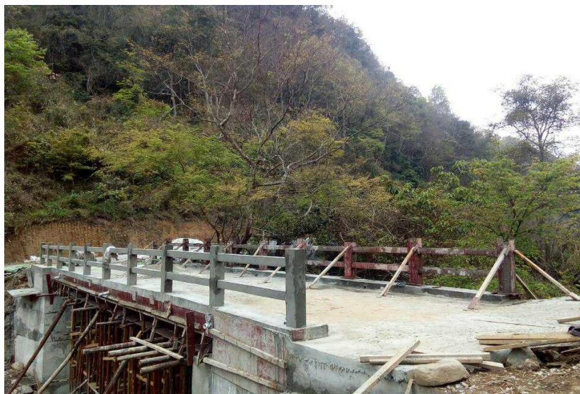
NO.286 田湾屯桥 (已竣工)
