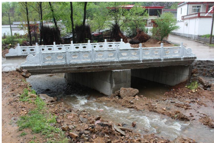
NO.288 陈沟爱心桥 (已竣工)
