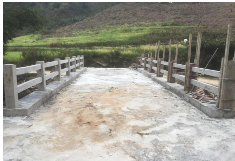
NO.285 点塘屯桥 (已竣工)
