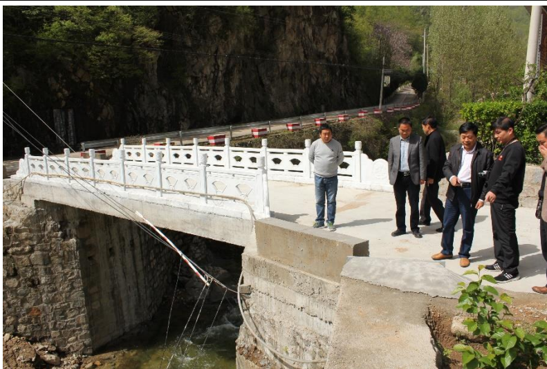
NO.290 西竹园爱心桥 (已竣工)
