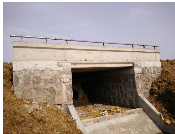
NO.299 新庄桥 (已竣工)
