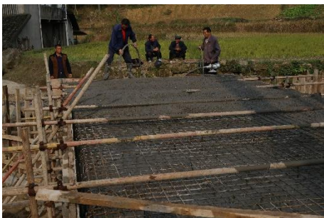
(14) 四川省开江县长岭镇山溪口村水竹林溪桥桥面浇筑
