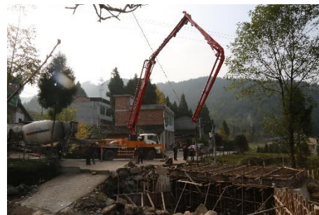
(14) 四川省开江县长岭镇山溪口村水竹林溪桥桥面浇筑
