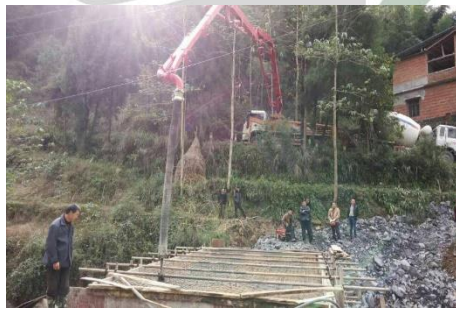
(14) 四川省开江县长岭镇山溪口村水竹林溪桥桥面浇筑
