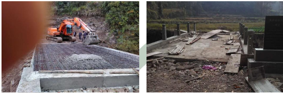
(17) 四川省宣汉县厂溪镇梨子村粽子沟溪桥
