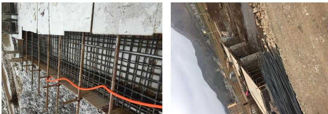
图四十:水磨镇水磨阿鲁块爱心桥桥面布筋浇筑
