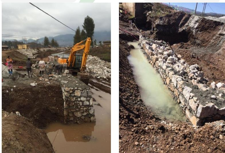
图三十九:水磨镇水磨阿鲁块爱心桥桥墩施工
