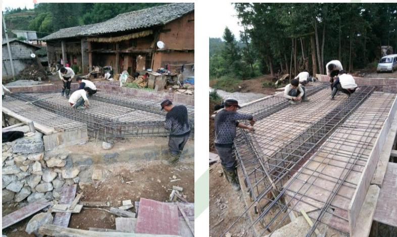
图十八：新街社区李家河边 20 社爱心桥桥面钢筋浇筑
